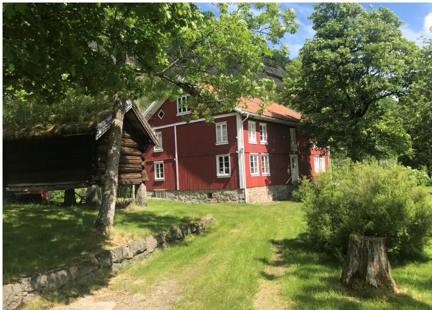
Lensmannsgarden på Fennefoss. Her skal Hans Nielsen Hauge ha budd da han besøkte bygda hausten 1803. Bygningen er no ein del av Setesdalsmuseet. Foto: Bjørg Seland, 2021. Gjengitt med tillatelse. Alle rettigheter er forbeholdt. Kan ikke gjenbrukes uten tillatelse.
