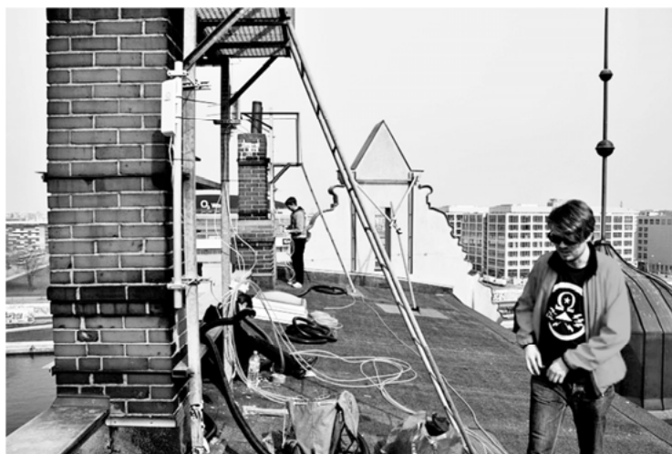
Abbildung 1: Freifunker*innen verlegen Kabel bei FluxFM
