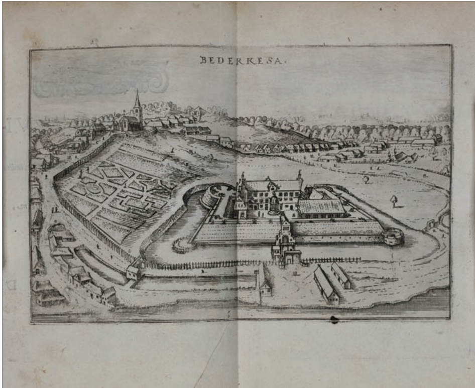
Abb. 5: Ansicht der alten Burg Bederkesa, Stich von Wilhelm Dillich. Die alte Festung der Bremer Bischöfe wurde nach 1720 zum Amt umgebaut, sie ist ein gutes Beispiel für die Erhaltung spätmittelalterlicher, geschichtlich bedeutender Gebäude durch die Folgenutzung als Amtshaus (Quelle: Niedersächsisches Landesarchiv, Standort Stade).
