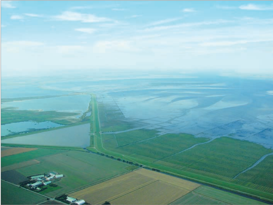
Abb. 8: Die letzte Großeindeichung 1987 von Salzwiesen und Watt war heftig umstritten. Der neue Deich verbessert den Küstenschutz und der entstandene Beltringharder Koog verbessert die Entwässerung von tief liegendem Hinterland und dient dem Naturschutz als Ausgleich für den Eingriff ins Wattenmeer. Vorne ein Gehöft im 1926 eingedeichten Sönke-Nissen-Koog. Das Deichvorland entstand durch Verlandungsarbeiten, die rechts im Bild aus Naturschutzgründen nicht mehr fortgeführt werden (August 2009).
