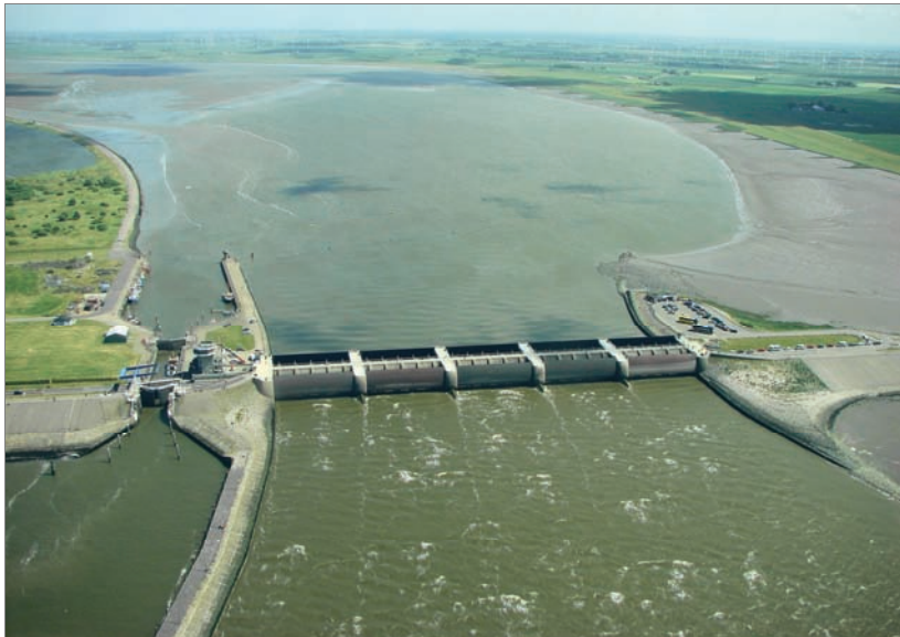
Abb. 7: Konfrontation zwischen Meer und Fluss: Eidersperrwerk bei ablaufendem Wasser und mit bei Sturmflut verschließbaren Toren, links eine Schiffsschleuse (Juni 2009).
