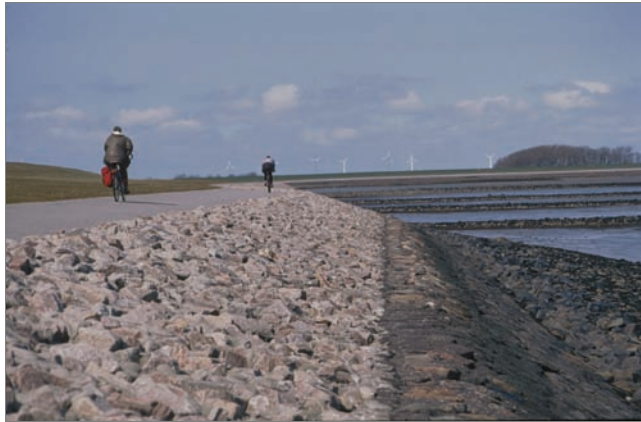
Abb. 6: Konfrontation zwischen Land und Meer: Massiver Deich, davor im Watt mit Steinbuhnen, um Sedimentabtrag zu verringern, am Deichfuß Steinschüttungen, die einer Unterspülung vorbeugen. Das mittlere Tidehochwasser reicht bis an den ersten Steinabsatz, die raue Steinpackung oberhalb soll Wellenenergie brechen. Der asphaltierte Weg ist für Baufahrzeuge, Abtransport von Treibsel und Rad fahrende Urlauber. Die mit Gras bewachsene Deichkrone liegt 6 m über mittlerem Hochwasser. Nördlich von Wyk auf Föhr (April 2004).
