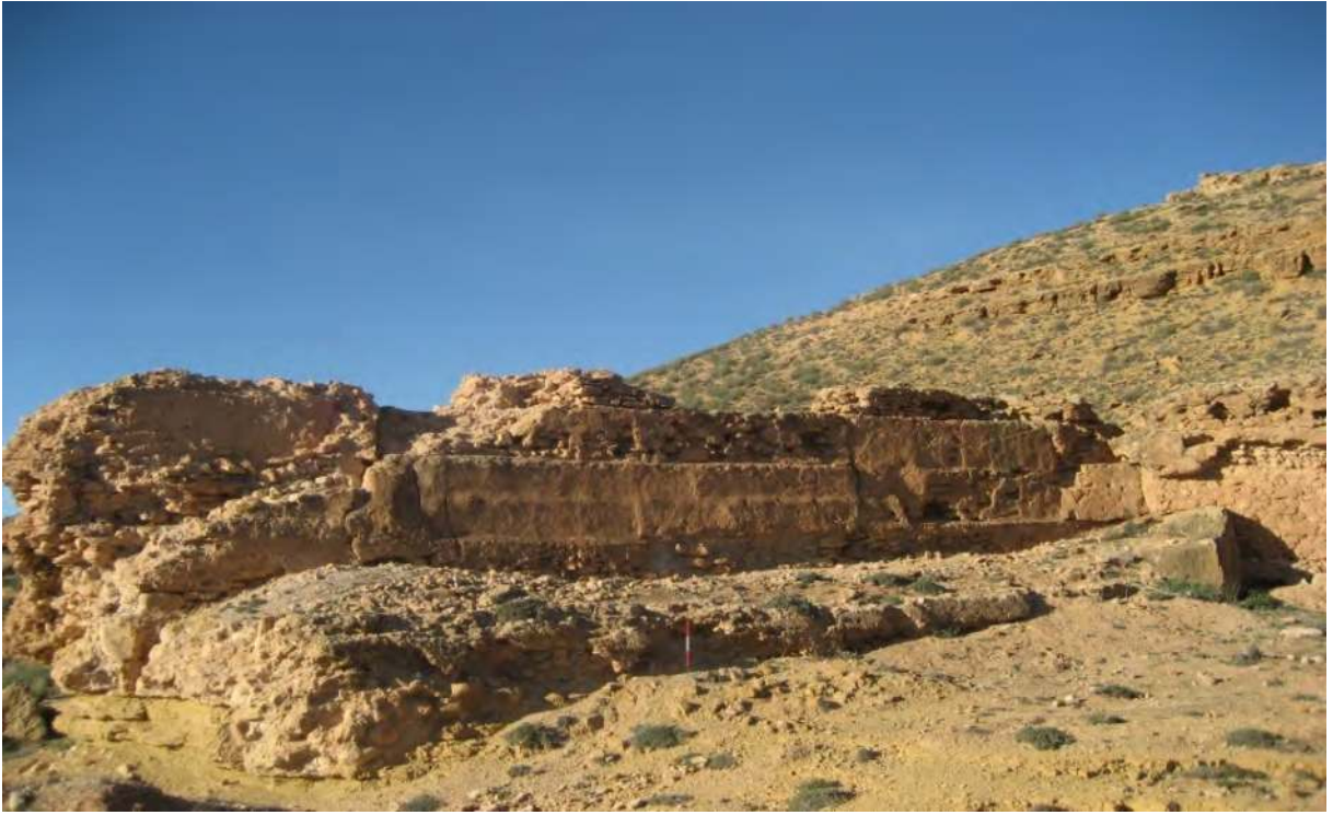
Figure 2.28: A dam in the Wadi Turgut (TUT24).
