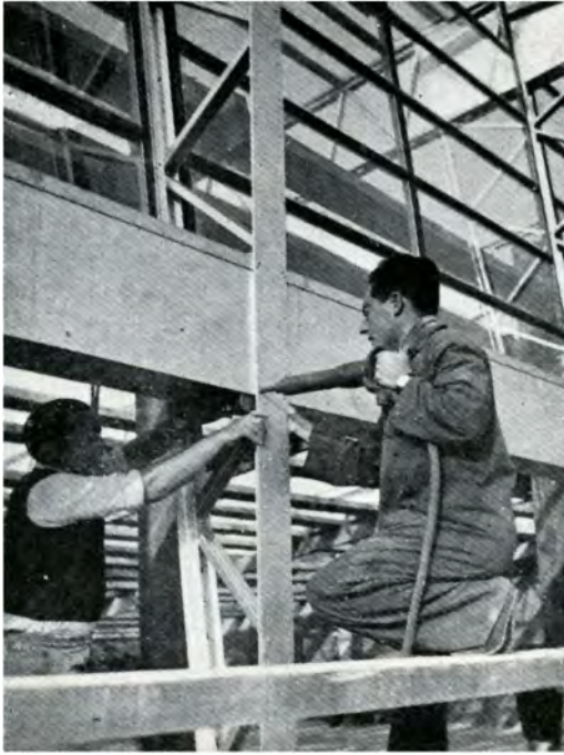
Figure 5. Riveting in progress. Image: 1956, Informes de la Construcción 79, 139–45.
