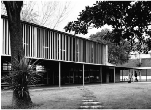
Figure 7. Louvres on the south façade of the dining hall. Archivo Histórico ETSAUN.
