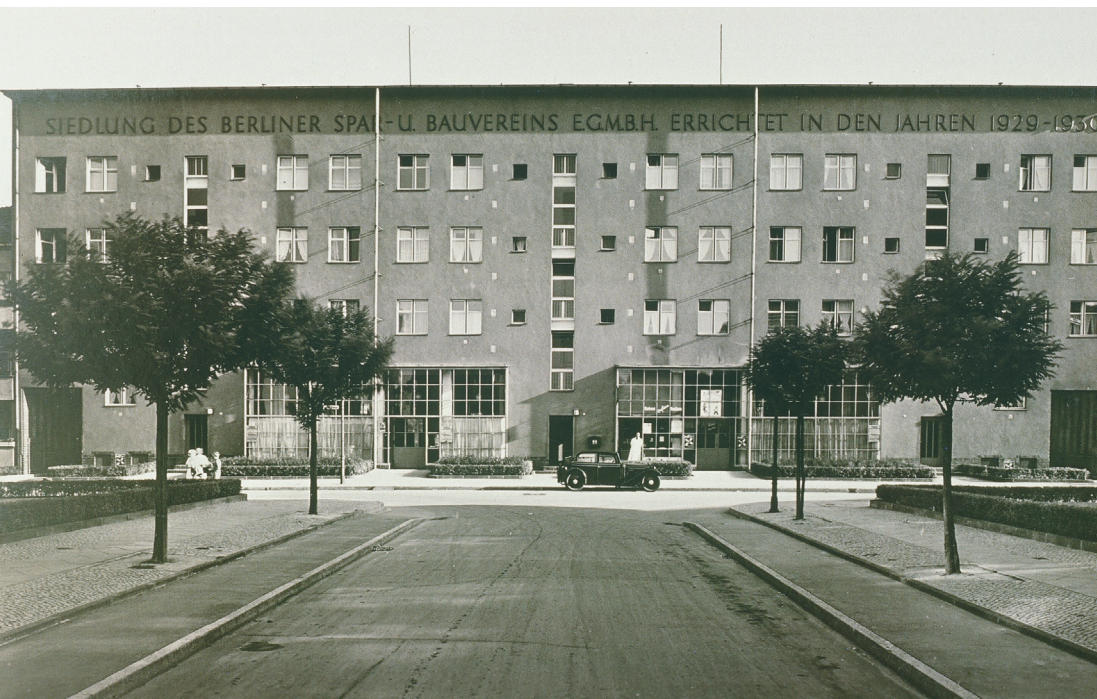
9 | Namenszug des Berliner Spar- und Bauvereins auf dem Eingangsgebäude der Siedlung Attilahöhe, um 1931.
