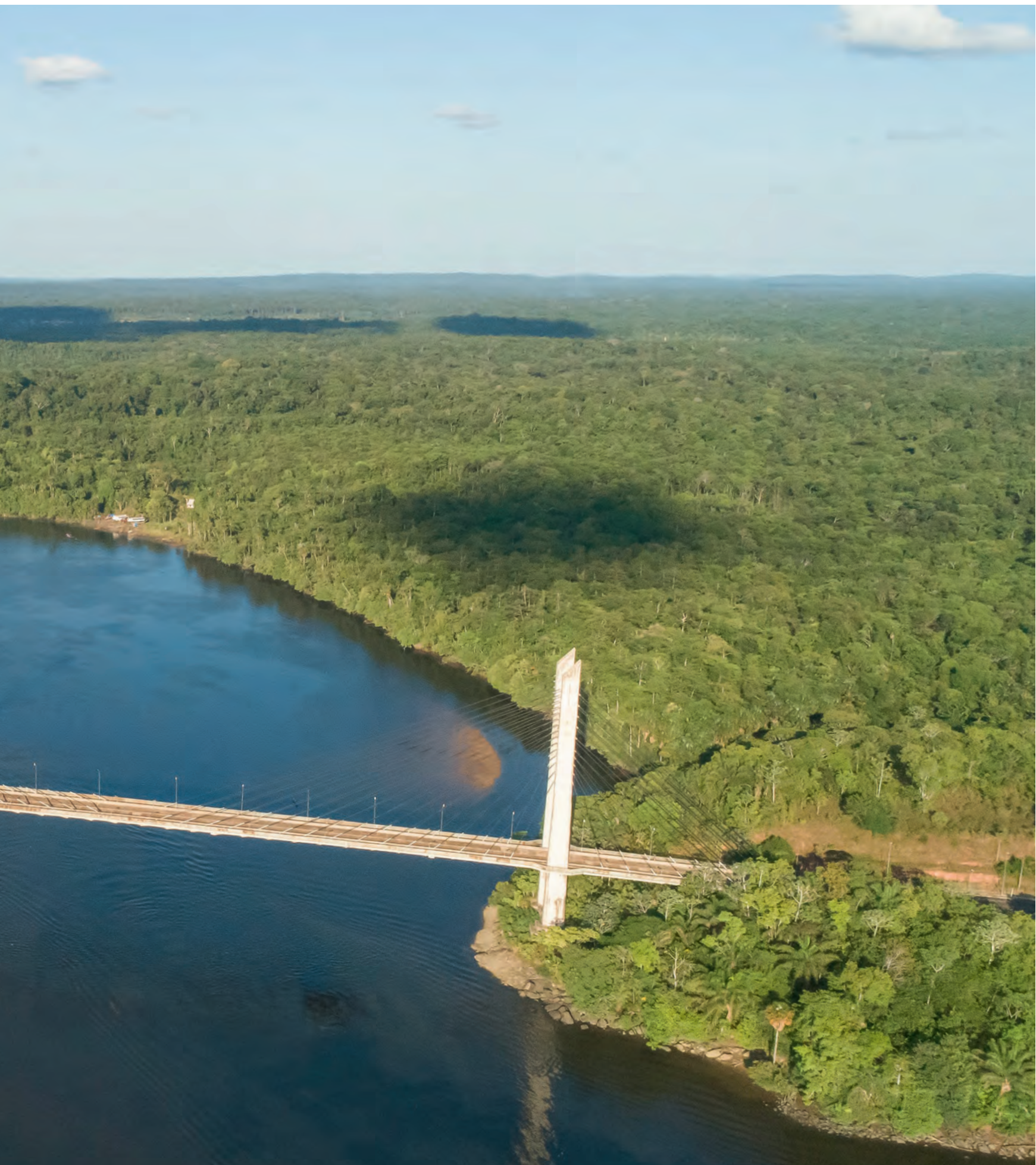
Vue aérienne du pont transfrontalier entre la Guyane et le Brésil.
