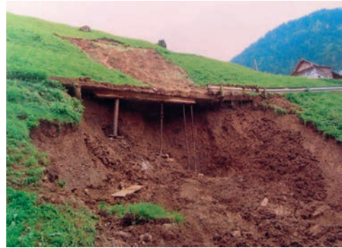
Foto 4: Zufahrt Betrieb Bergblick, Oberrickenbach
