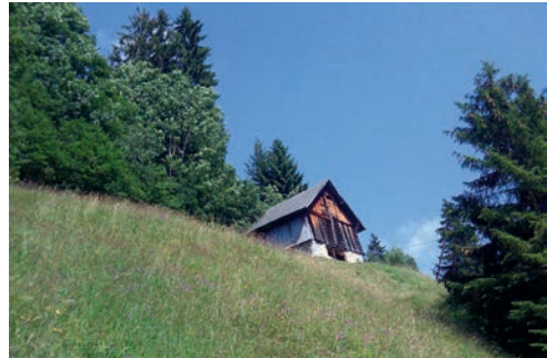
Foto 63: Alte Scheune II Quelle: LW 10
