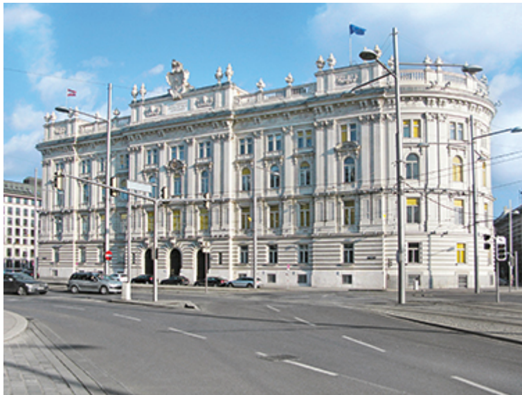
20. Karl König , Haus der Industrie, Vienna 3, Schwarzenbergplatz no. 4, built around 1906 / Prokop
