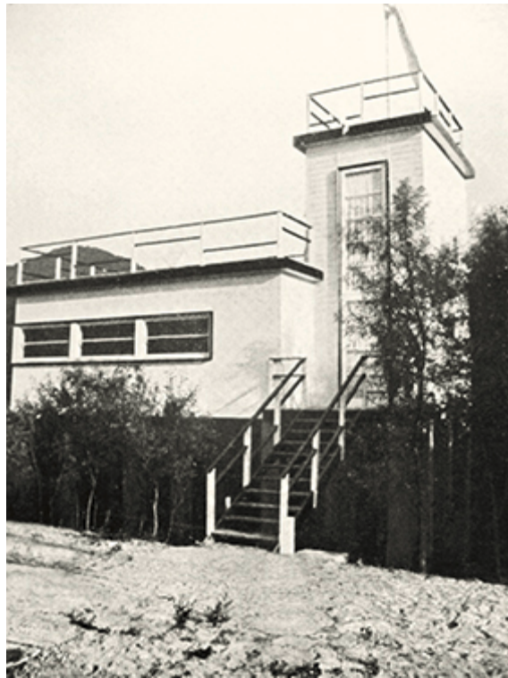
76. Ernst Schwadron , Lederer House, Greifenstein, Lower Austria, built in 1927 / Österreichs Bau- und Werkkunst 1928
