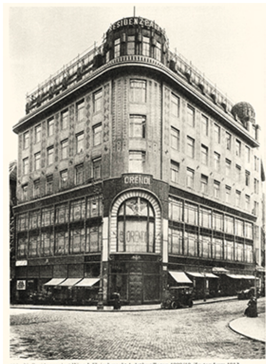
25. Arthur Baron , Residenzpalast, Vienna 1, Fleischmarkt no.1, built 1910 / Der Bautechniker
