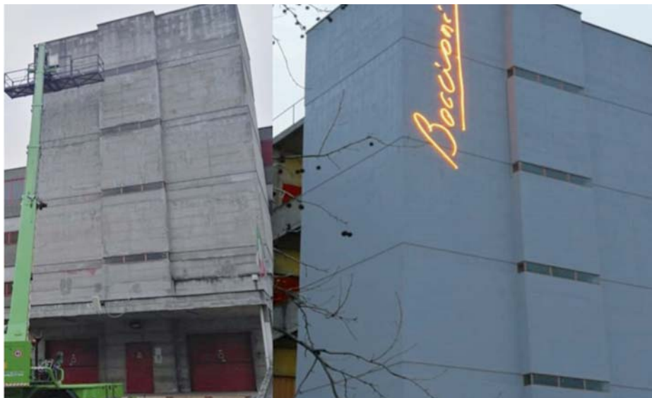
Fig. 3 – Il magazzino multipiano, prima e dopo il restauro
