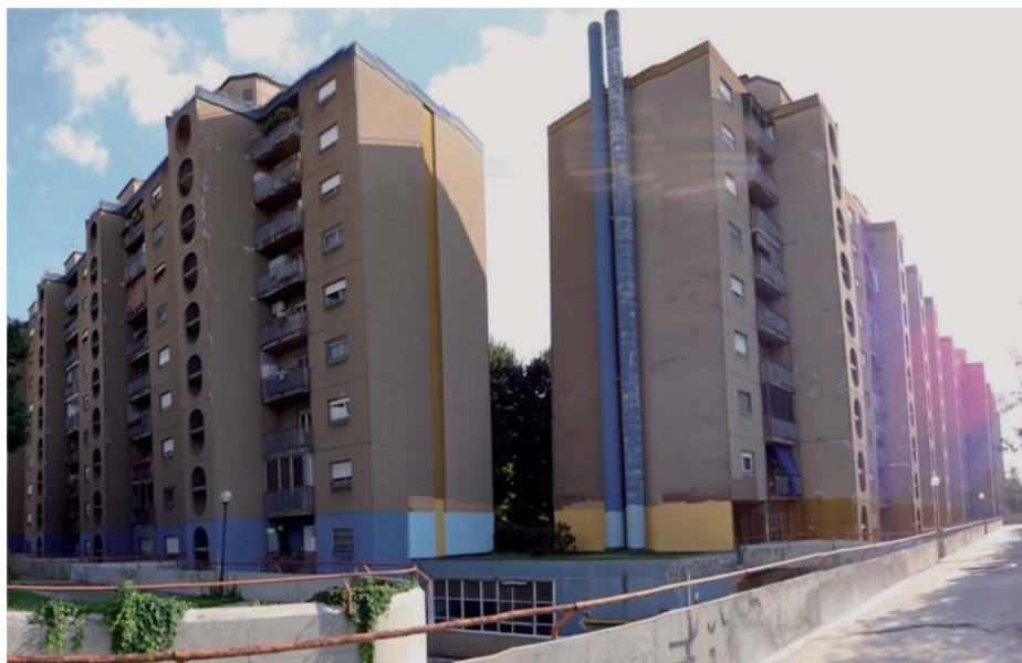
Fig. 1 - Esempi di immobili di edilizia residenziale pubblica, in stato di progressivo degrado, situati in un quartiere periferico con significativa presenza di residenti stranieri (via Rizzoli-via Capraro)
