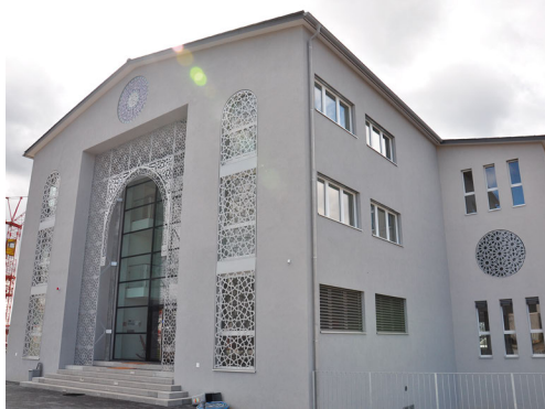
Abbildung 12: ImanZentrum, Außenansicht, Zürich 2013.
