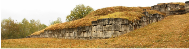
Abb. 4: Abschnitt der Befestigungsmauer von Blidaru. Foto von R. Mateescu (nach Pescaru et al. 2014, 13, Abb. 2).
