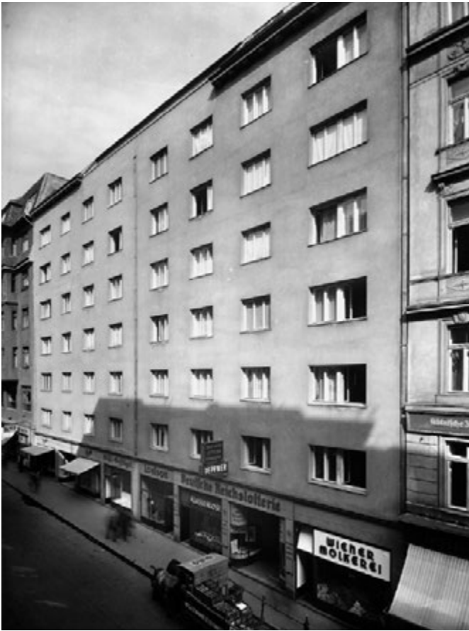
Abb. 26 1939 fertig gestellter Wohnbau im Sanierungsgebiet I., Wollzeile 21/23 vom Johann Eggenfelder. (Foto Reiffenstein 1942).
