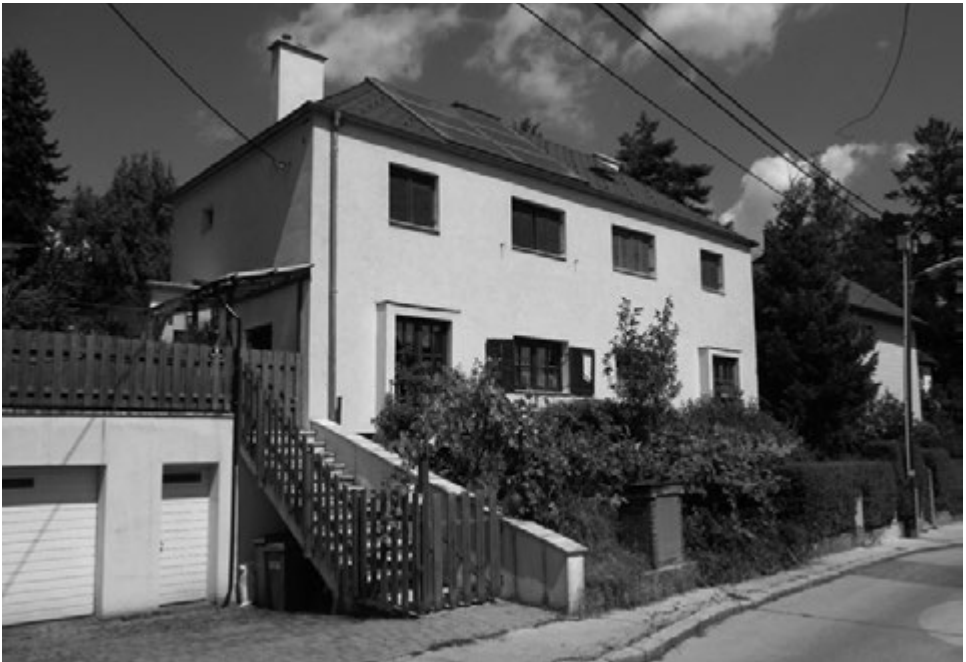
Abb. 70 1936 am XIV., Freesienweg 8–6 errichtetes Doppelwohnhaus der größeren Type von den Architekten Winkler und Kraft. [Andreas Suttner 2016].
