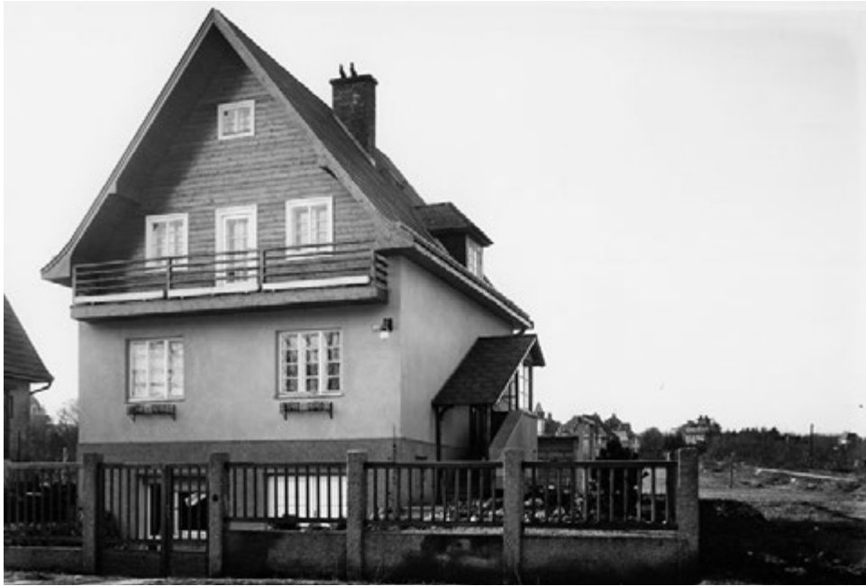
Abb. 75 Zweifamilienhaus des Assanierungsfonds von 1937/38 in der XIX., Erocigasse 33. Das Haus ist nicht mehr erhalten. [Foto Gerlach 1937].
