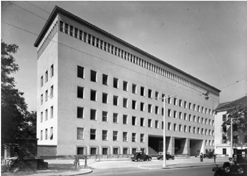
Abb. 87 Monumentales Funkhaus der Österreichischen Radio-Verkehrs AG in der I., Argentinierstraße 30–30a von Clemens Holzmeister, Heinrich Schmid und Hermann Aichinger. (Anonym 1937).
