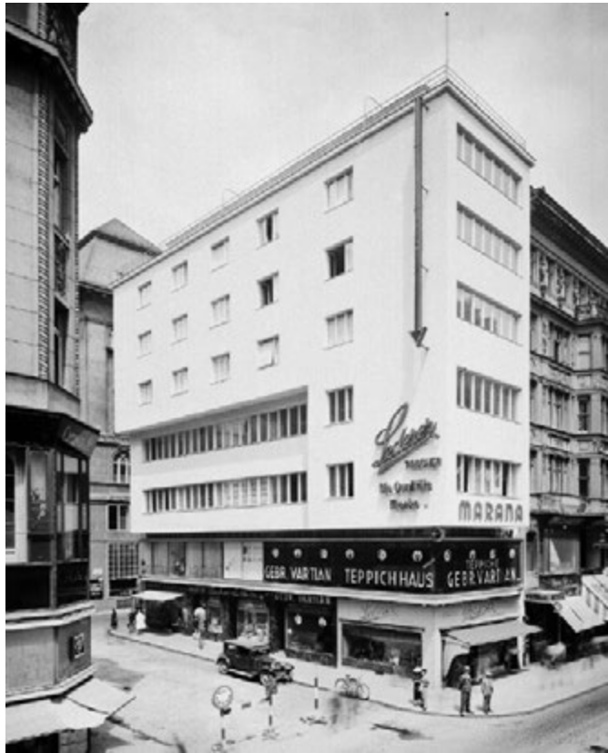
Abb. 22 Das Stadthaus zum Römertor I., Lichtensteg 2/ Rotenturmstraße 15/Rotgasse 2 von Schmid und Aichinger war der erste geschweißte Stahlhochbau in Wien und eines der ersten drei Häuser des Assanierungsfonds. (Anonym 1935/36).
