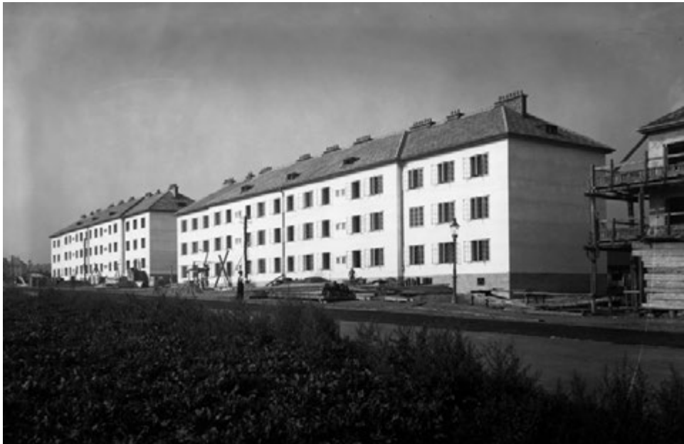
Abb. 76 Fertig gestellte Häuser in der XI., Hasenleitengasse 6–14 im Jahr 1937. Die Gartenstadtsiedlung wurde von Morzin Aemilian Servé geplant. [Martin Gerlach 1937].
