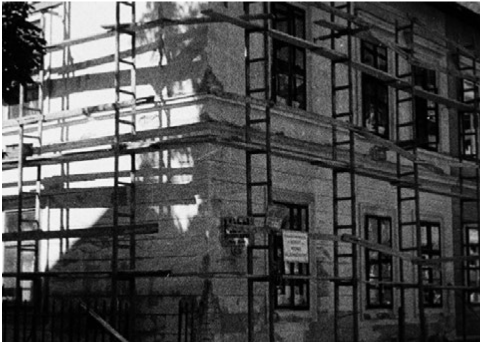
Abb. 28 Im Zuge des Hausreparaturfonds durchgeführte Fassadenerneuerung. (Anonym um 1935).
