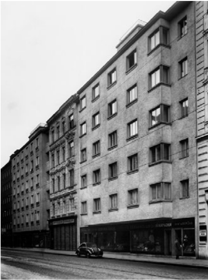
Abb. 37 Abgesetzte Geschäftszone beim Assanierungsbau in der VII., Lerchenfelder Straße 81, 85/89 [Foto Gerlach 1937].
