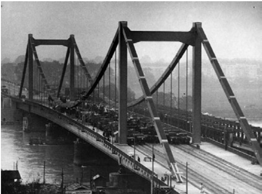
Abb. 19 Belastungsprobe der Wiener Reichsbrücke bei der Eröffnung am 10. Oktober 1937. (Albert Hilscher 10.10.1937).
