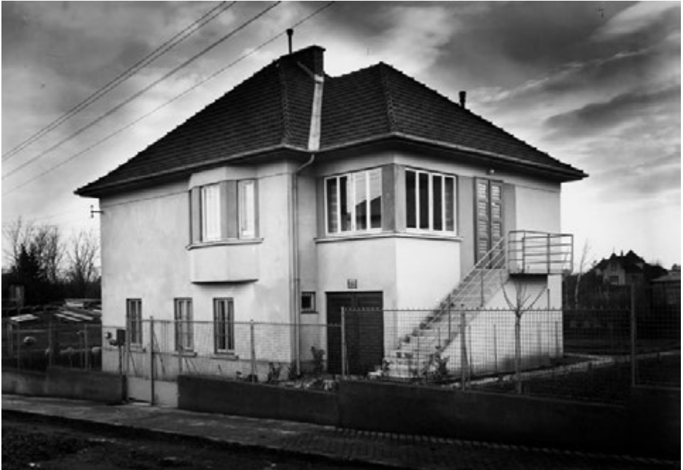
Abb. 74 Privates Wohnhaus von 1935/36 in der XIII., Dostojewskigasse 22–24 von Robert Kalesa. [Foto Gerlach 1937].
