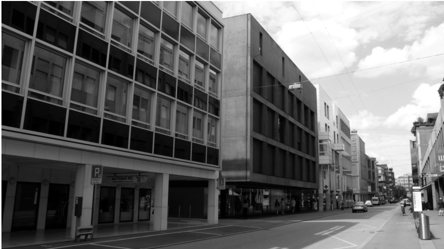
Abbildung 1: 194 Firmen sind in diesem 4-stöckigen Gebäude (rechts) in der Bahnhofstraße 7 in Zug ansässig. Beschriftete Türklingeln und Briefkästen gibt jedoch nur fünf. Foto: Celia Di Pauli.
