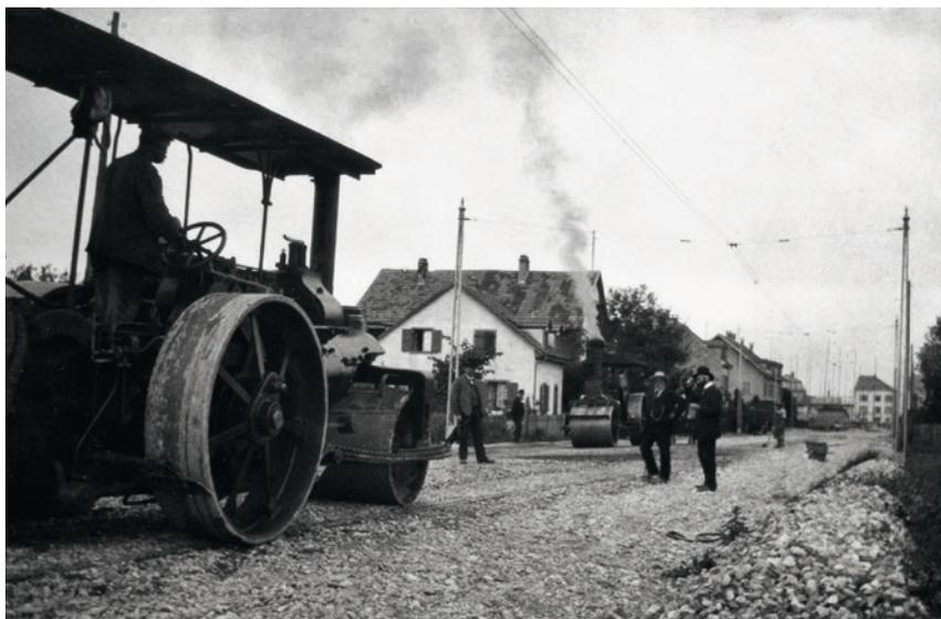
Abbildung 23: Walzen einer Strasse in Allschwil, Kanton Baselland, 1905. Das Komprimieren der Strassenoberfläche durch das Walzen reduzierte die Staubbelastung vorübergehend.<sup>415</sup>
