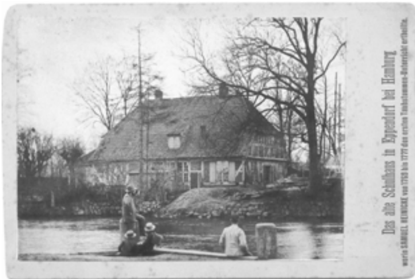
Abbildung 4: Das Küster- und Schulhaus in Eppendorf
