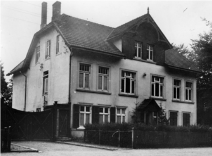
Abbildung 65: Altenheim am Mellenbergweg
