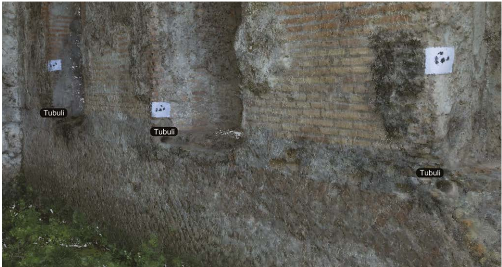
Fig. 7/ Annotazione su nuvola di punti del condotto idraulico costituito da tubuli
