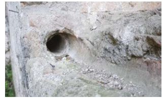
Fig. 6a-b/ Particolari della condotta inserita sotto il piano delle nicchie.
