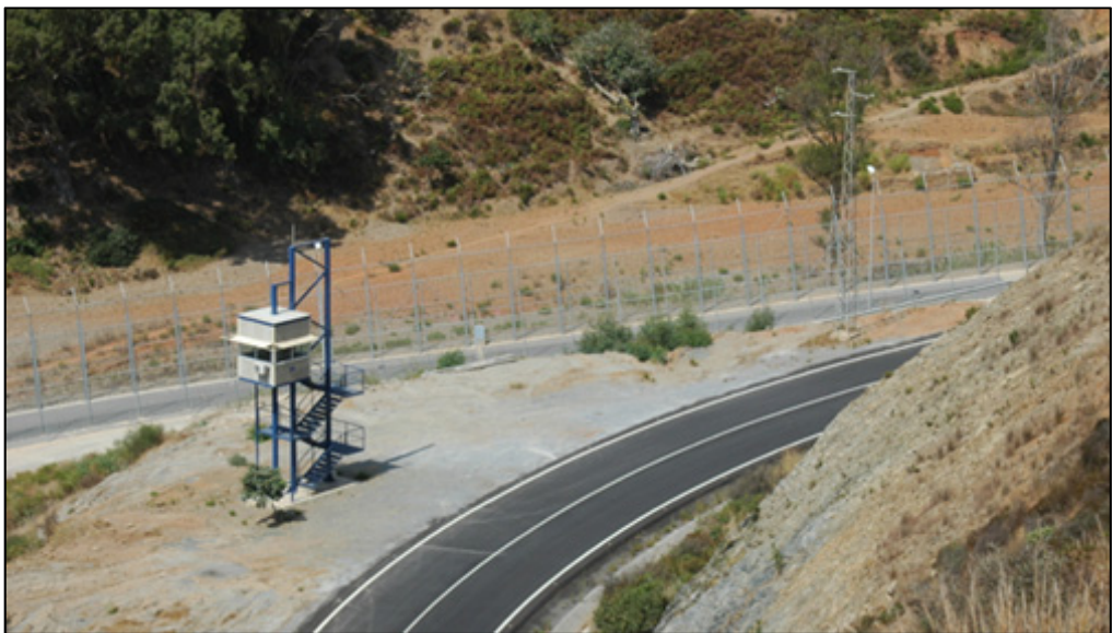
Abbildung 1: Grenzanlage in Ceuta
