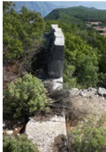
4. Türschwelle, Südwand in situ nach Osten
