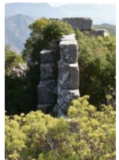
8. Nordwand nach Osten
