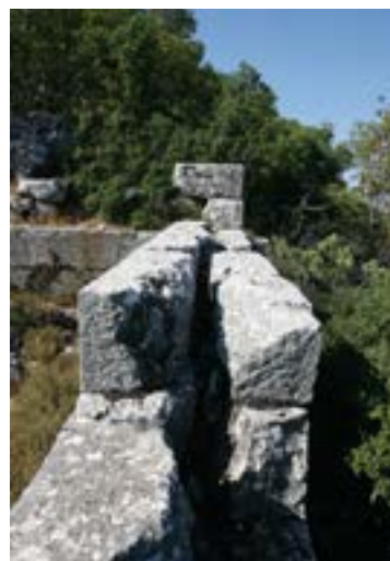
7. Nordwand nach Westen
