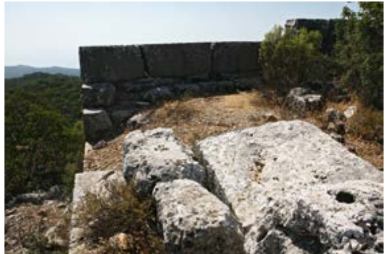
2. Südwand innen, Südost-Ecke
