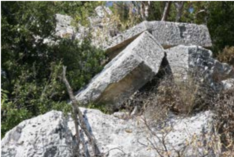
1. Abdeckplatten der Frieze, Südseite außen: Trysa, Versturz
