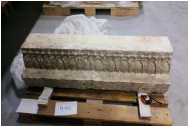
3. Abdeckplatte der Frieze, Südseite außen
