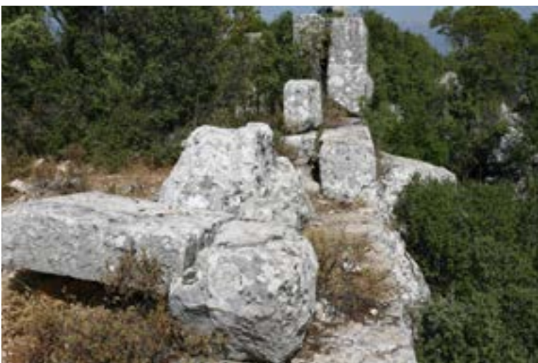
6. Ostwand nach Norden
