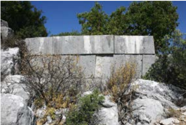
1. Südwand außen, West
