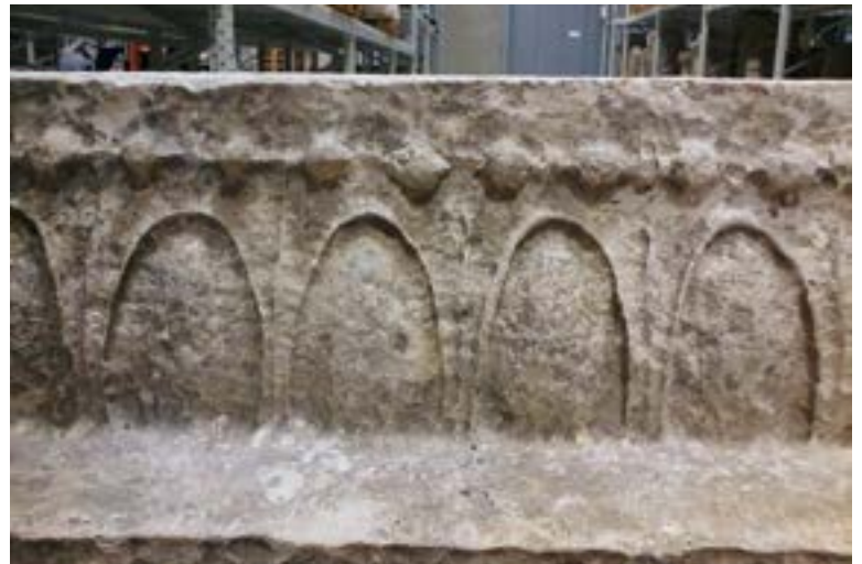
4. Abdeckplatte der Frieze, Südseite außen
