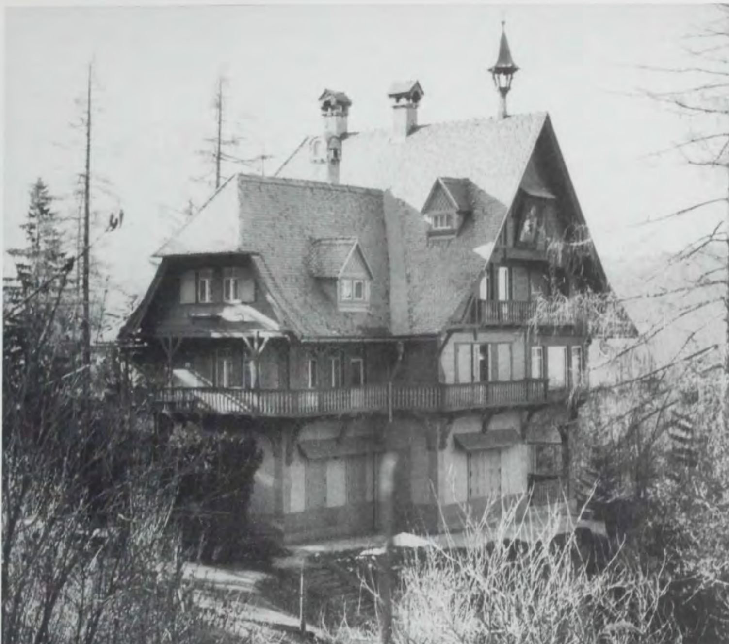
94, 95. Villa Leibenfrost, 1899, Außenansicht
