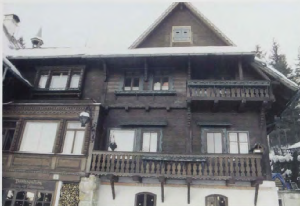
184. Villa Schönthaler, 1895, westlicher Gebäudeteil
