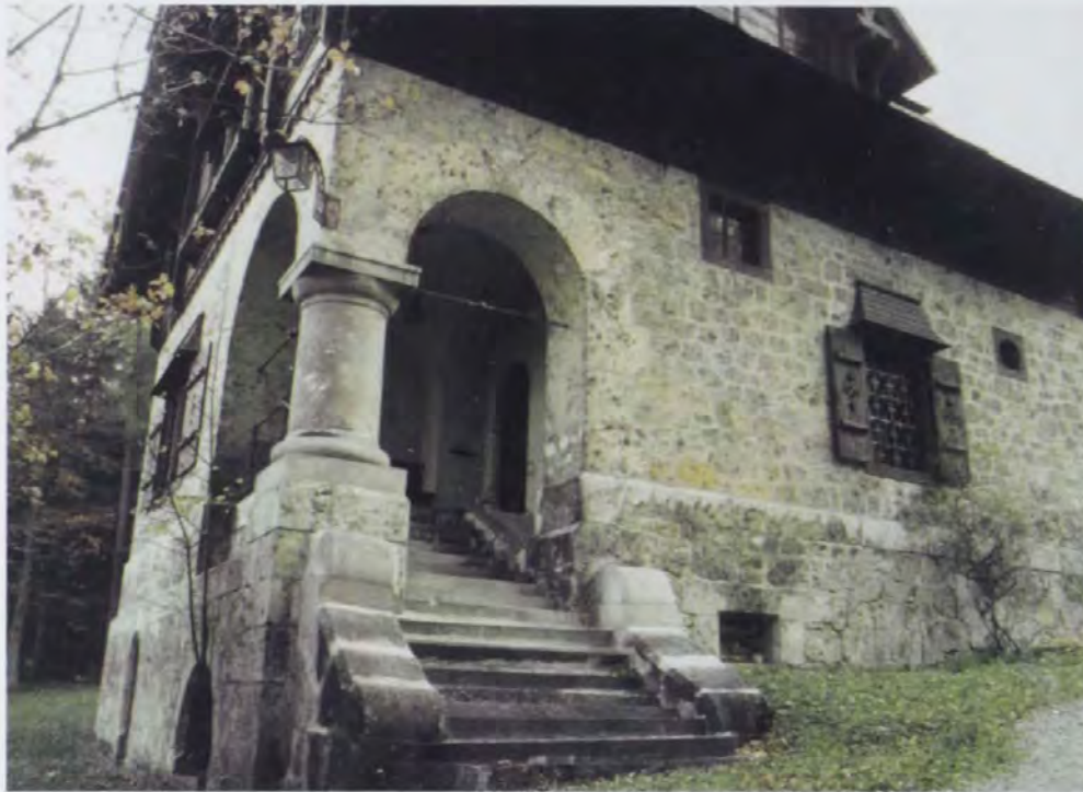
198. Jagdhaus des Fürsten Liechtenstein, 1890, Gebäudeecke
