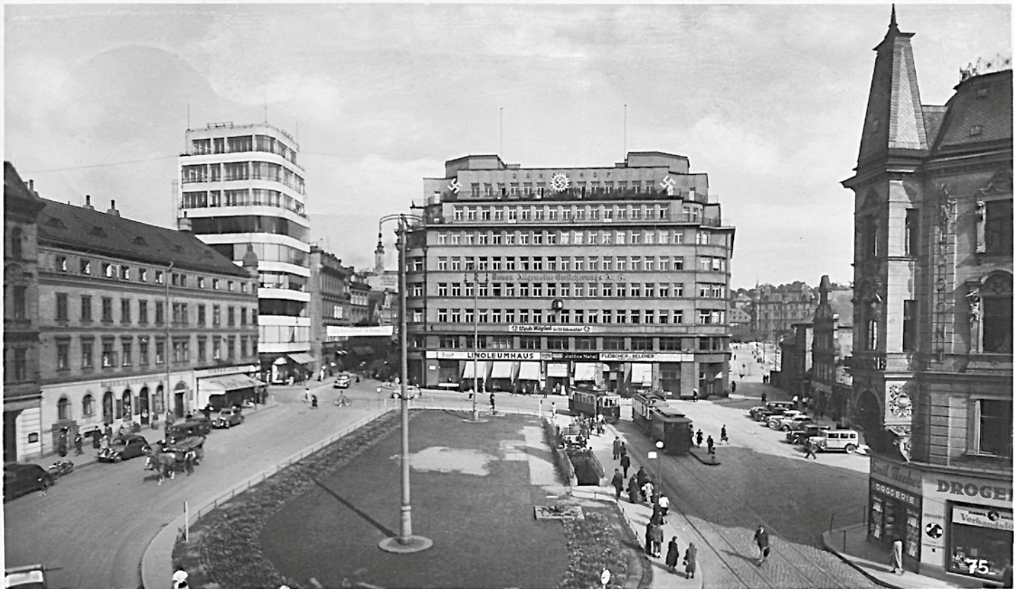
Platzbauwerk, Donauhof gegenüber Platz.
