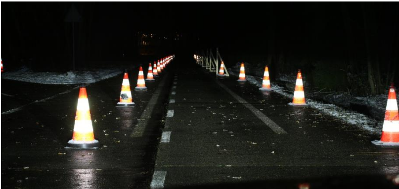
Abbildung 4.4: Baustellensituation mit eingeschaltetem Baustellenlicht
