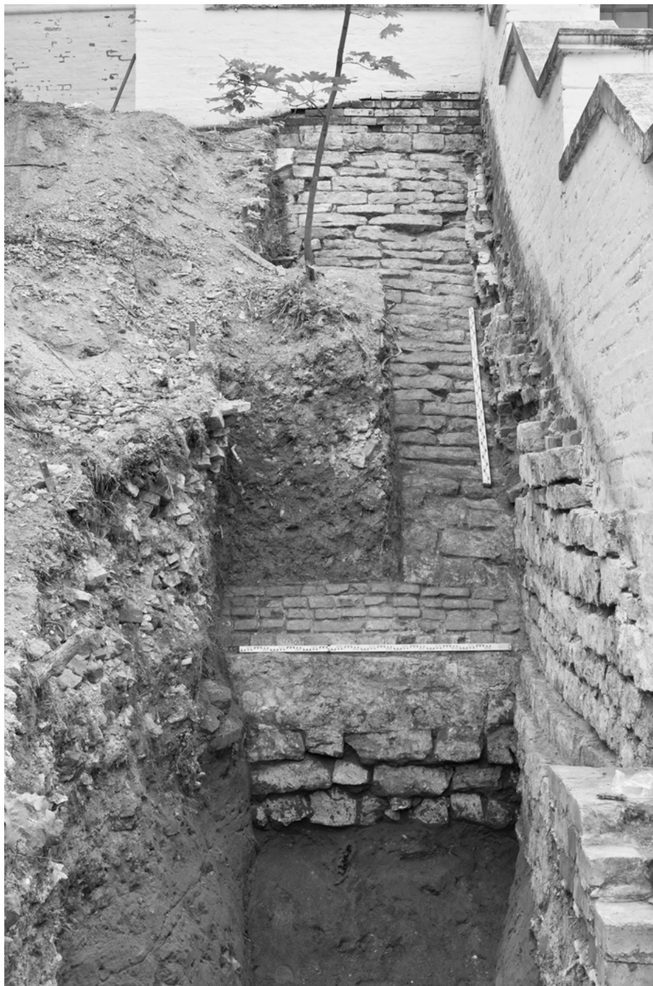
Abb. 5 Stützmauer für den Klosterhügel (18. Jahrhundert)
