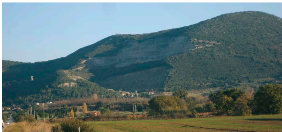
Fig. 3.6 Cavarocce, cava di prestito, Gavorrano
