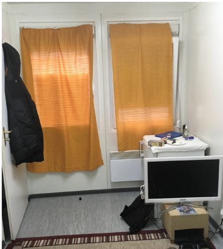
Abb. 4.49 Vorhänge, die über Heizkörpern hängen, müssen gekürzt werden um das Brandrisiko zu verringern.
