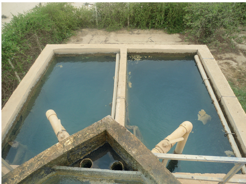
Décanteur statique à flux ascendant, Thiago (Sénégal)
