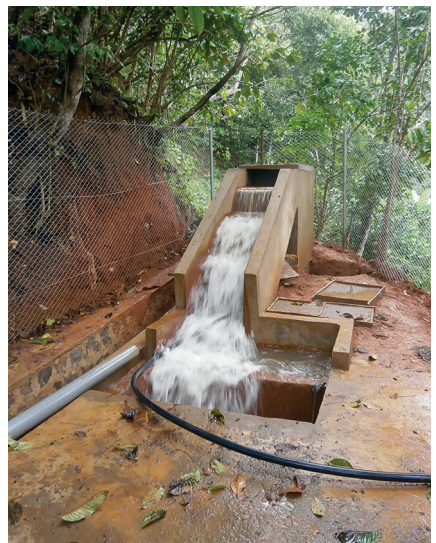
Cascade d'aération en béton
