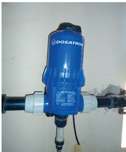
Pompe doseuse hydraulique (type Dosatron)
