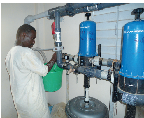
Pompe doseuse hydraulique, station de Ziré (Mauritanie)
