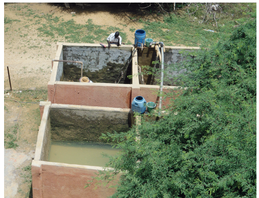
Décanteurs de Tékane (Mauritanie)
