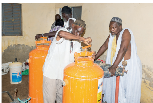
Ouverture du filtre sous pression, Guidakhar (Sénégal)
