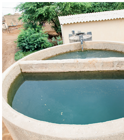
Bassin de décantation, station de Guidakhar (Sénégal)
