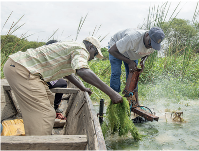
Nettoyage de la prise d'eau à Bokhol (Sénégal)
