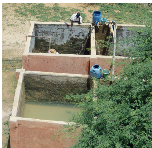
Décantation par batch, station de Tékane (Mauritanie)
