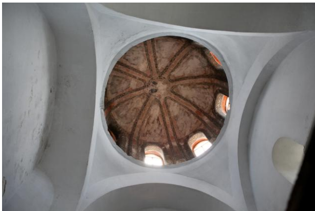
Fig. 23 – Istanbul, Vefa Kilise Camii, esonartece, interno, cupola sud
