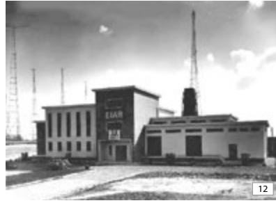
Figura 11. Il Centro ad Onde Medie EIAR di Santa Palomba.
