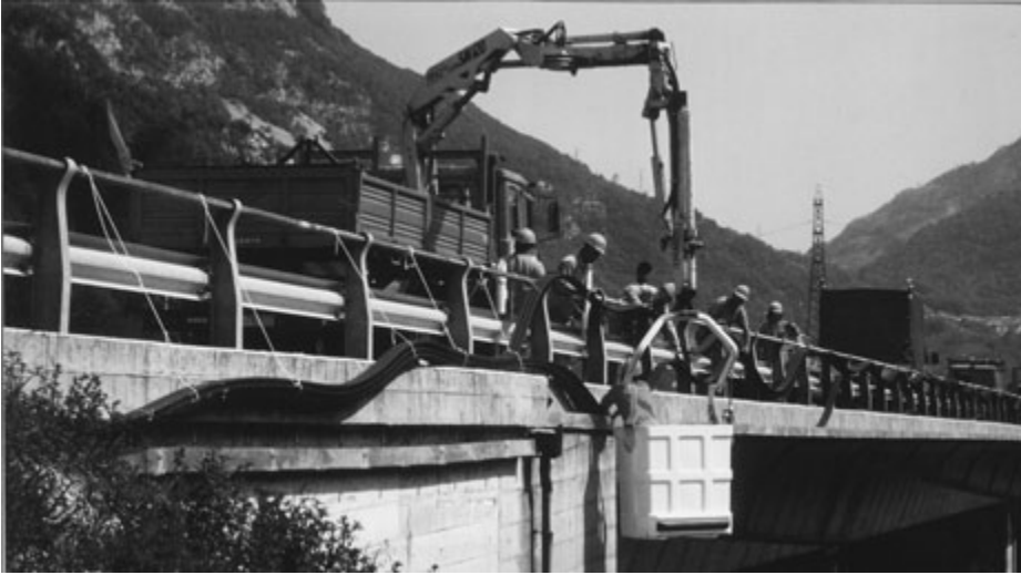
Figura 11. Installazione di tritubi lungo un viadotto.
