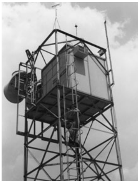
Figura 6. Traliccio dell'impianto sperimentale per la misura dell'attenuazione da pioggia realizzato nella piana del Fucino dalla Fondazione Ugo Bordononi alla fine degli anni '60. Si nota, oltre all'antenna la strumentazione pluviometrica.
