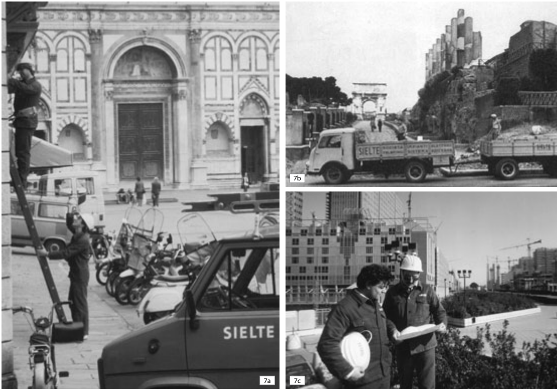
Figura 7. Lavori in rete urbana: Firenze (a), Roma (b) e Napoli (c).
