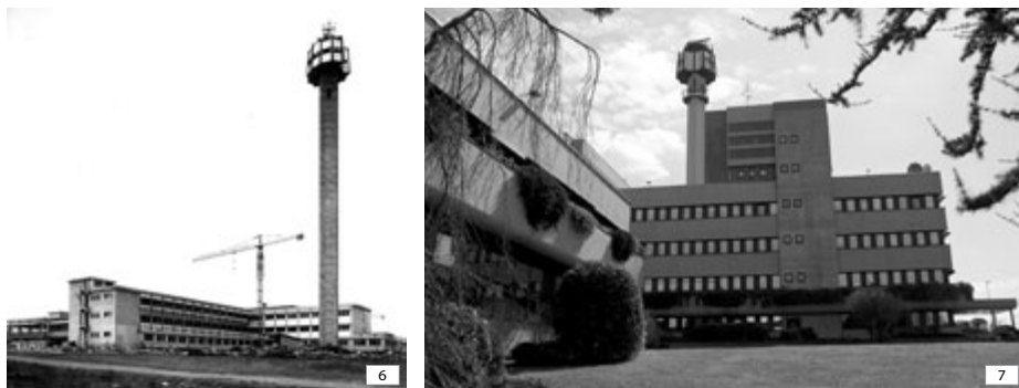
Figura 6. Costruzione della sede CSELT di via Reiss Romoli (1967).
