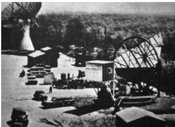
Figura 5. Vista generale della stazione di Holmdel (N.J.) del progetto Echo: a sinistra l'antenna trasmittente con riflettore paraboloidico; a destra, quella ricevente con riflettore a tromba; entrambe in montaggio altazimutale (da Enciclopedia Italiana di Scienze Lettere Arti , 1960, voce "Radiocomunicazioni" a cura di A. Niuatta, Appendice III, vol. II, pp. 558-564).
