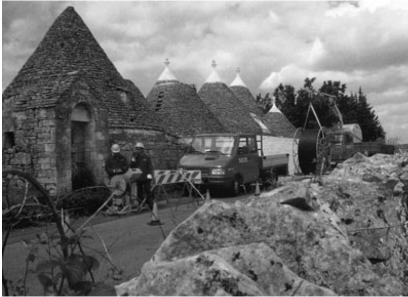
Figura 10. Installazione di cavo ottico in rete distrettuale.
