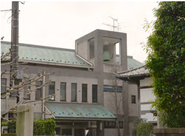
Abbildung 253: # 448 Kōmyōji 光明寺 Gemeindegebäude Waka kaikan 和香会館 mit Glockenturm auf dem Aufzugschacht (Yokohama, Baujahr unbekannt, Jōdoshū), © Jonas Gerlach.
