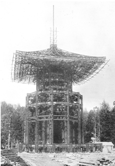
Abbildung 67: # 450b Kongōbuji 金剛峯寺 Konpon daitō 根本大塔 (Ito, 1937, Shingonshū), Ansicht während der Bauarbeiten 1936/37, Foto gemeinfrei.
