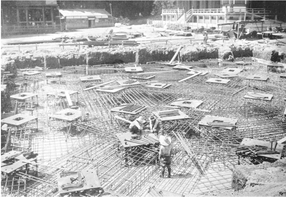
Abbildung 66: # 450b Kongōbuji 金剛峯寺 Konpon daitō 根本大塔 (Ito, 1937, Shingonshū), Ansicht während der Bauarbeiten 1936/37, Foto gemeinfrei.
