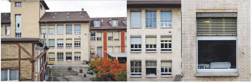
Abbildung 8: Fassadenausschnitt Gebäude LP 190
