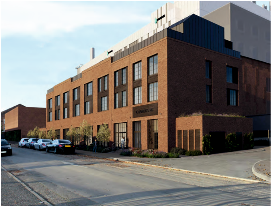
Abb. 10 Das Chandos Road Estate Rechenzentrum: Ein kleinteiliges Puffergebäude schirmt den öffentlichen Raum vom logistikintensiven Rechenzentrum ab. © Vantage Data Centers
