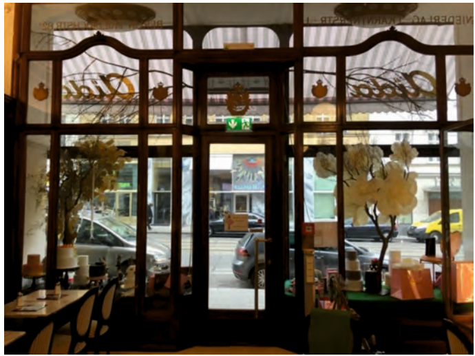
Abb. 6 Portale, Holz-Glas-Konstruktionen, die der eigentlichen Erdgeschossfassade vorgesetzt sind und den Austausch zwischen innen und außen in Szene setzen © Psenner 2020
