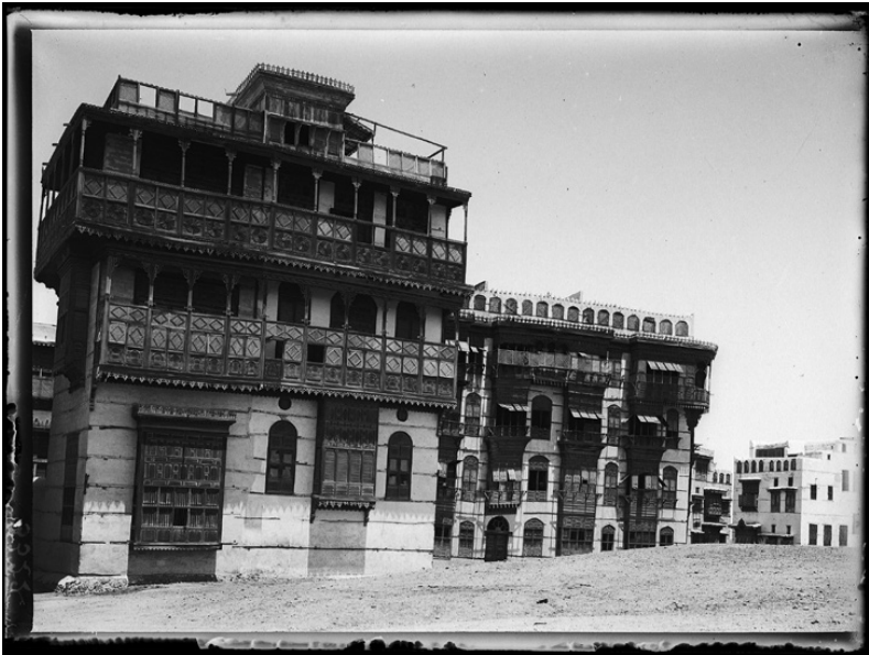
Figure 1.5 Building with open balconies in al-Shām quarter, 1917. Photo: Raphaël Savignac. © École biblique et archéologique française de Jérusalem.
