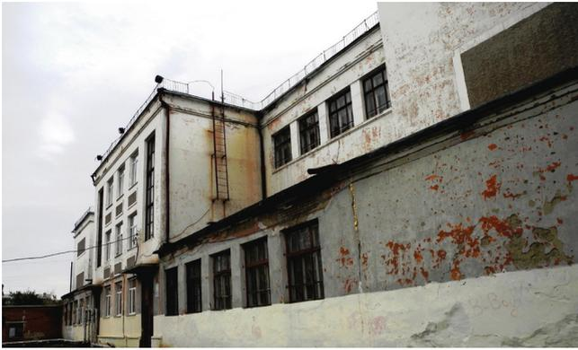
Abb. 7: Orsk, Schule im 8. Quartal, Hofansicht mit ursprünglicher konstruktivistischer Farbe und Fassadengliederung, Zustand 2012. Foto: Astrid Volpert.
