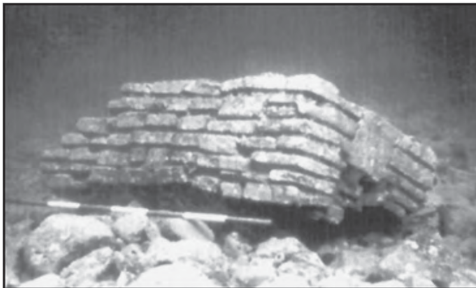
Tronca : segment de mur en opus latericium immergé (tiré de Medaglia (2010), p. 186, fig. 168)
