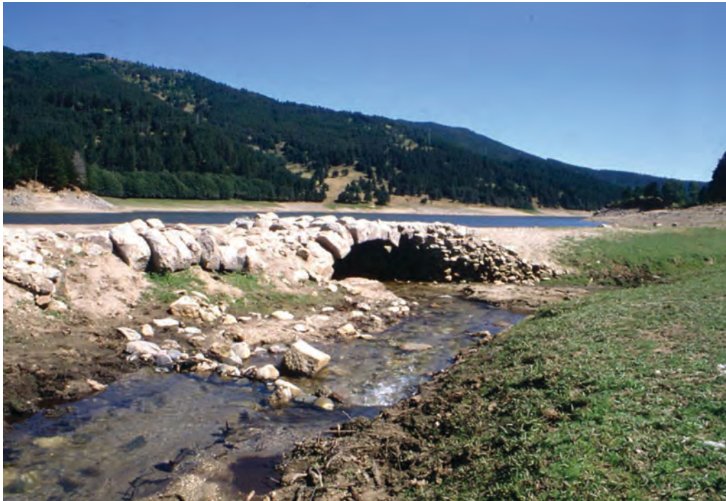
Pl. 6 a) Timparello dei Ladri : le pont romain ; vue en direction du nord-ouest (photographie D. Marino)
