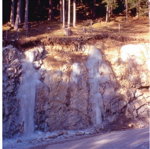
■ **Abb. 8.17** Gefrierender Zwischenabfluss an einem Forststraßenanschnitt. In dem Fall hätte wegen des anstehenden Festgesteins bereits ein Anschnitt des Hanges von einem halben Meter gereicht, um eine vollständige Exfiltration des Zwischenabflusses zu erzwingen (Bildquelle: Karl Auerswald)
