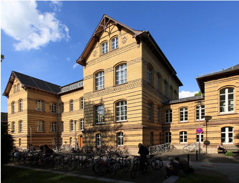
Abb. 31: Das Pathologische Institut (1891–1978) (Westansicht des Hauptgebäudes) Aufnahme 2009 (heute: Goßlerstraße 10)
