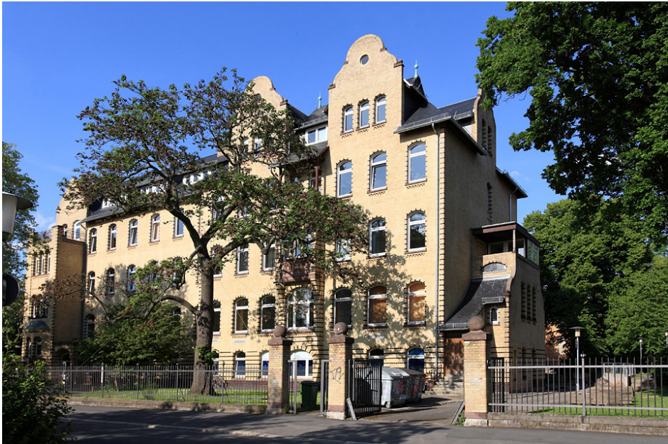
Abb. 25: Die Augenklinik (1906–1979) (Westansicht des Hauptgebäudes) Aufnahme 2009 (heute: Goßlerstraße 10)
