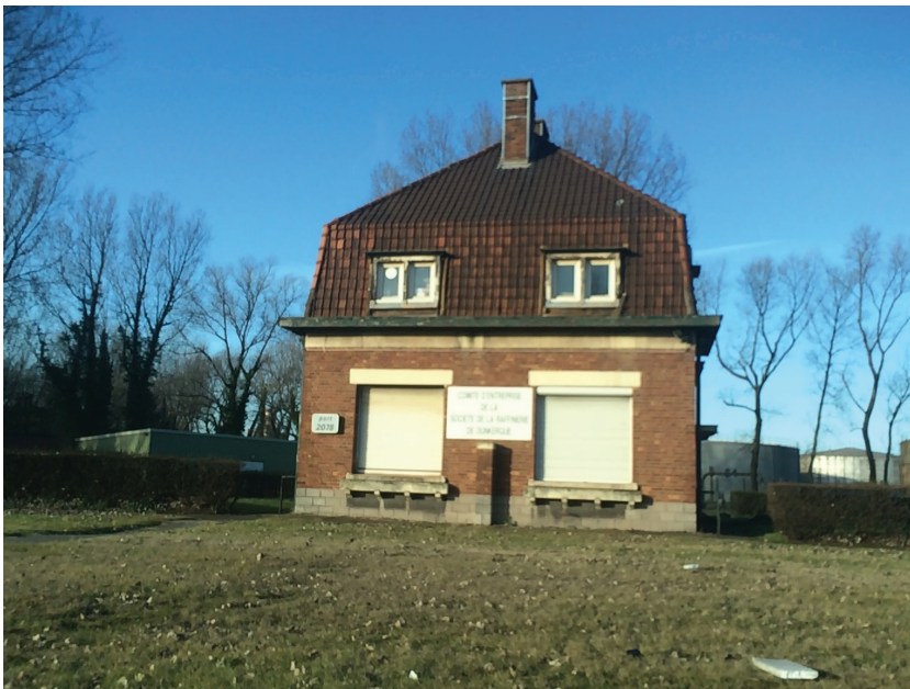
FIGURE 15.6 Abandoned building of the Comité d'Entreprise of the Société de la Raffinerie de Dunkerque. Source: Carola Hein.
