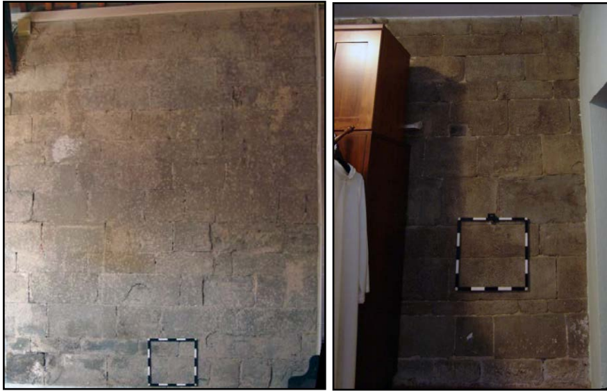
Figura 91. Chiesa di San Giovanni Evangelista: particolari della muratura degli originali fianchi esterni (rispettivamente sinistro e destro)
