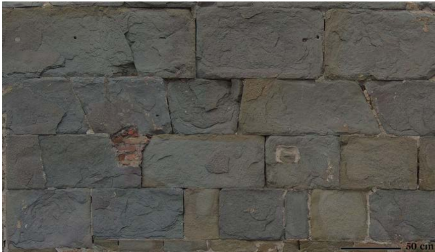
Figura 72. Sant'Ansano: particolare del paramento di XI secolo
