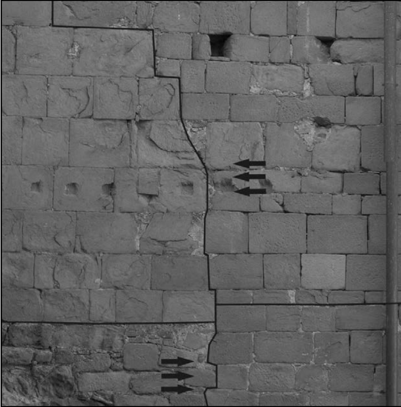
Figura 66. Abbazia di San Martino in Campo: particolare del paramento murario del lato occidentale, con indicazione delle Unità Stratigrafiche Murarie identificate ed i rapporti tra di esse
