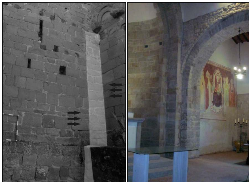
Figura 58. Abbazia di San Martino in Campo: a sinistra, dettaglio del pilastro inglobato nella ricostruzione di XII secolo e dei rapporti stratigrafici con le circostanti murature dell'abside e della navata laterale; a destra, lo stesso pilastro all'interno della chiesa
