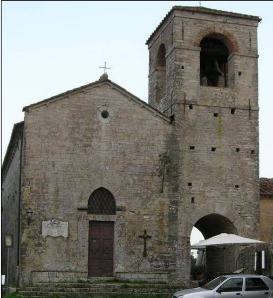
Figura 106. Chiesa di San Nicolao a Monsummano Alto: vista della facciata e del campanile
