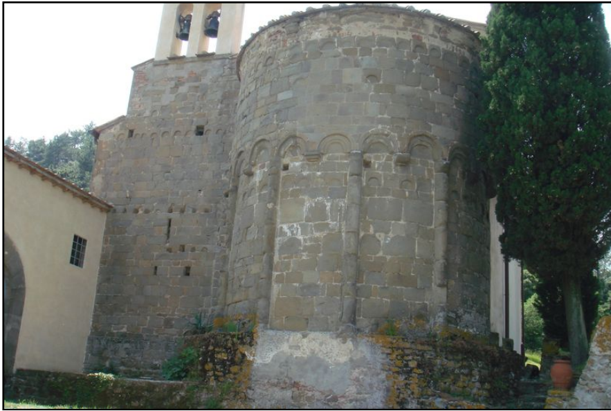
Figura 65. San Martino in Campo: veduta della zona absidale
