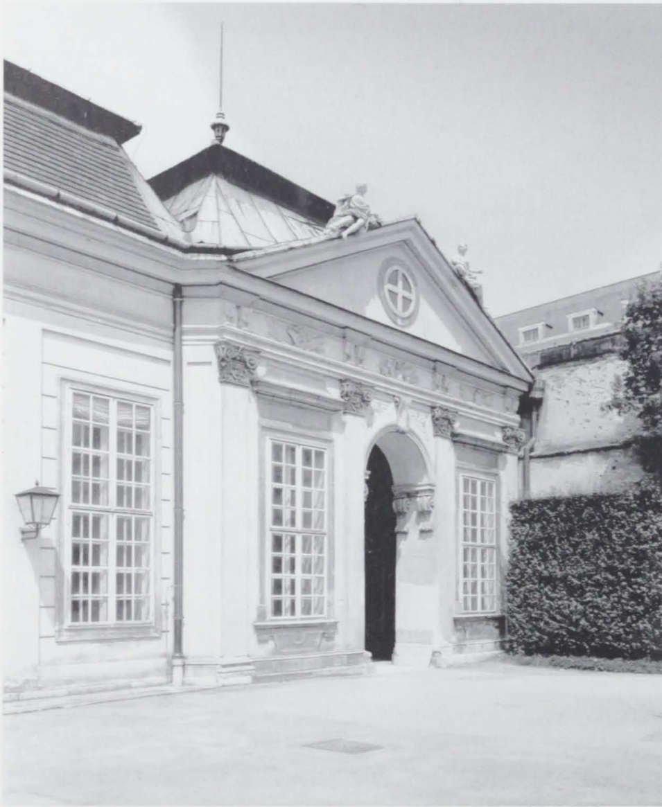
Abb. 112: Unteres Belvedere, Gartenseite, östlicher Eckpavillon mit Durchfahrt
