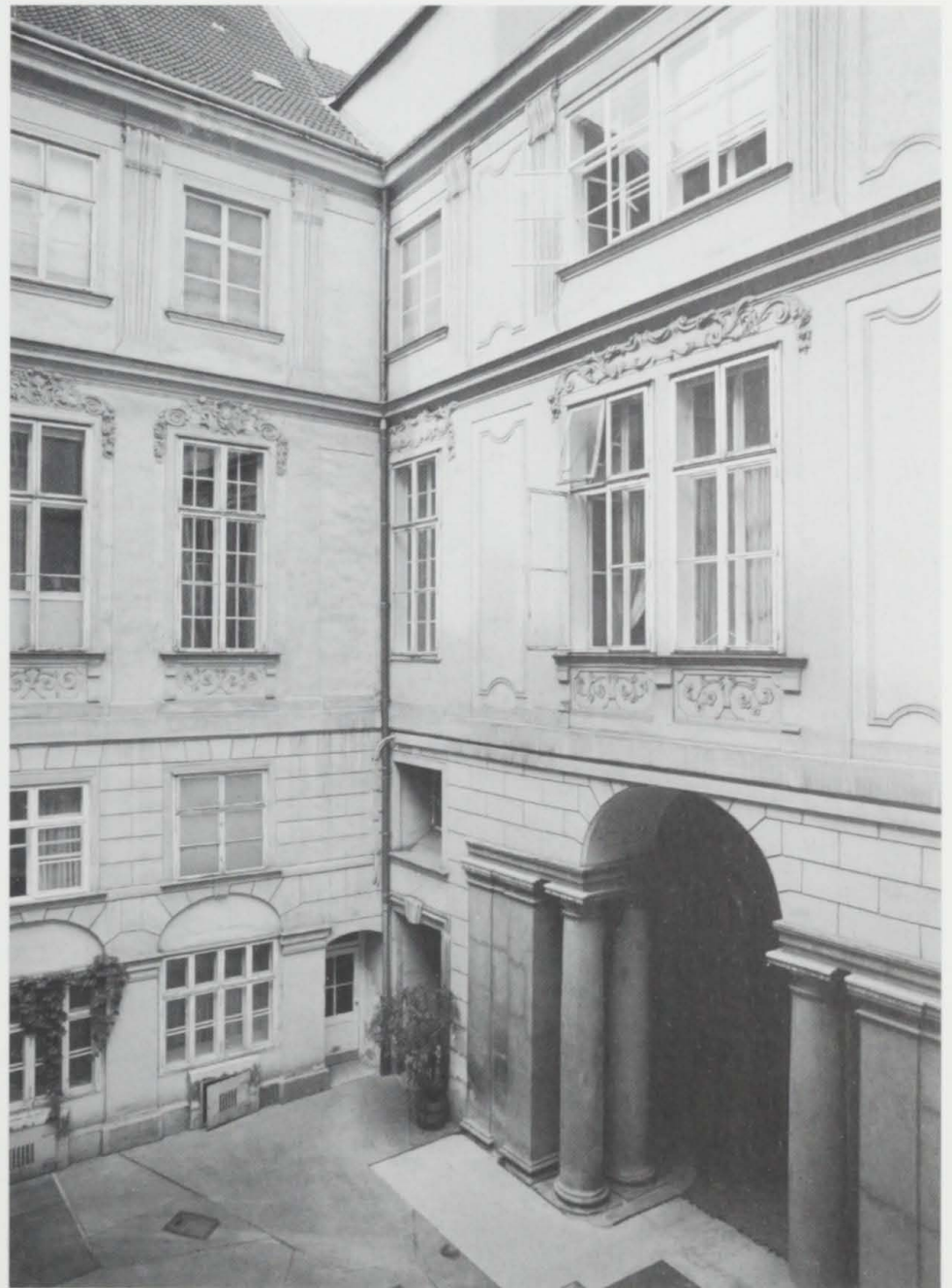
Abb. 13: Stadtpalais des Prinzen Eugen, Hof am Ende des Grundstücks, Nordwestecke
