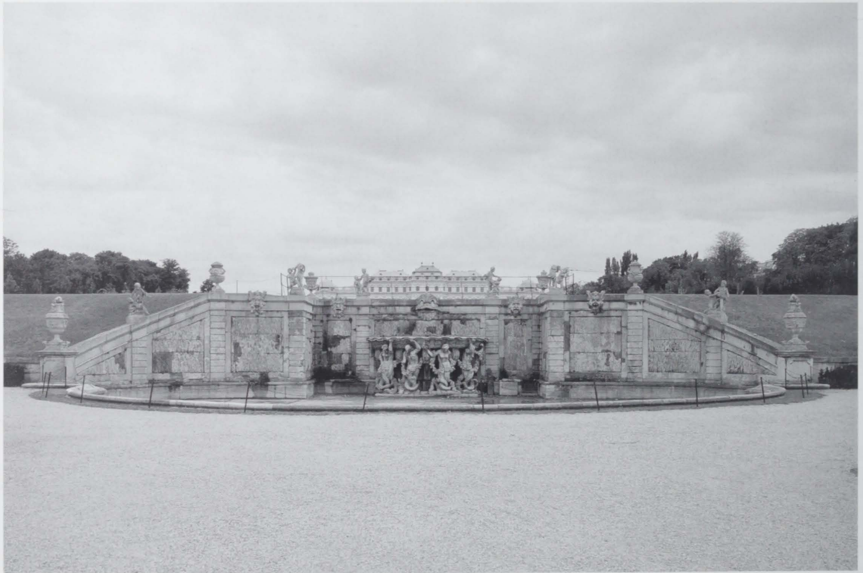
Abb. 89: Belvederegarten, Kleine Kaskade am feldseitigen Ende der Boskettzone
