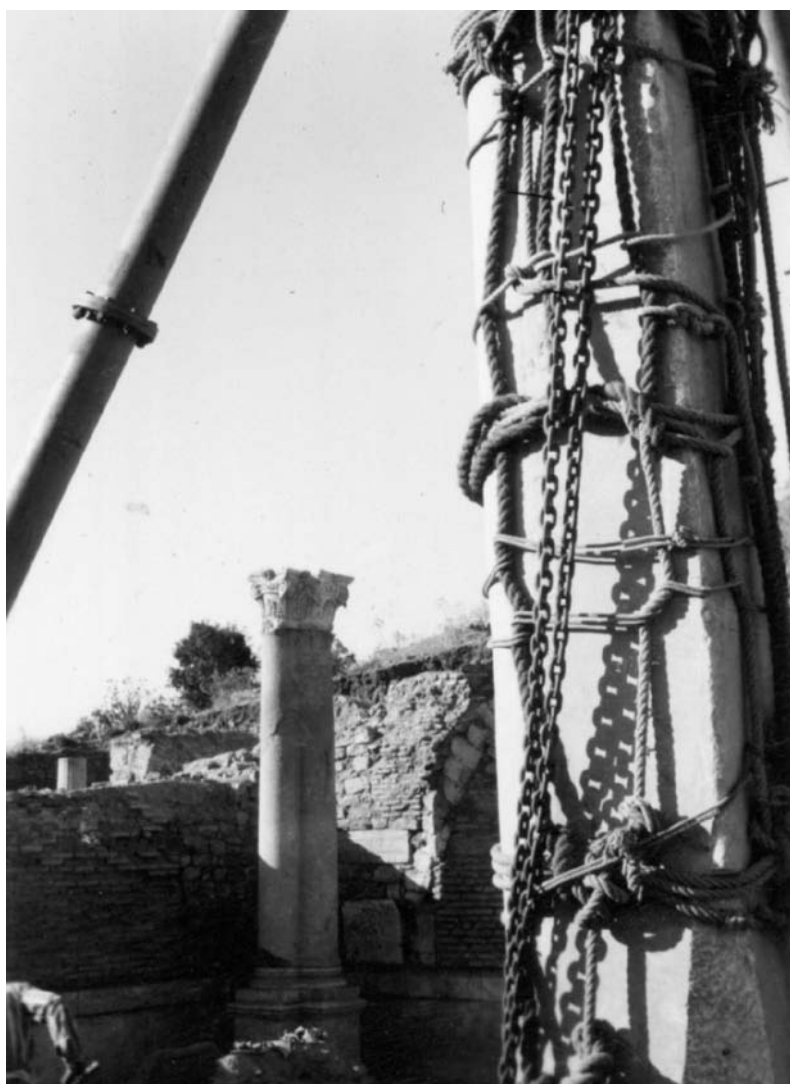
2 Anastylose des südöstlichen Säulenschaftes (A 16) des »Hestiasaal«
