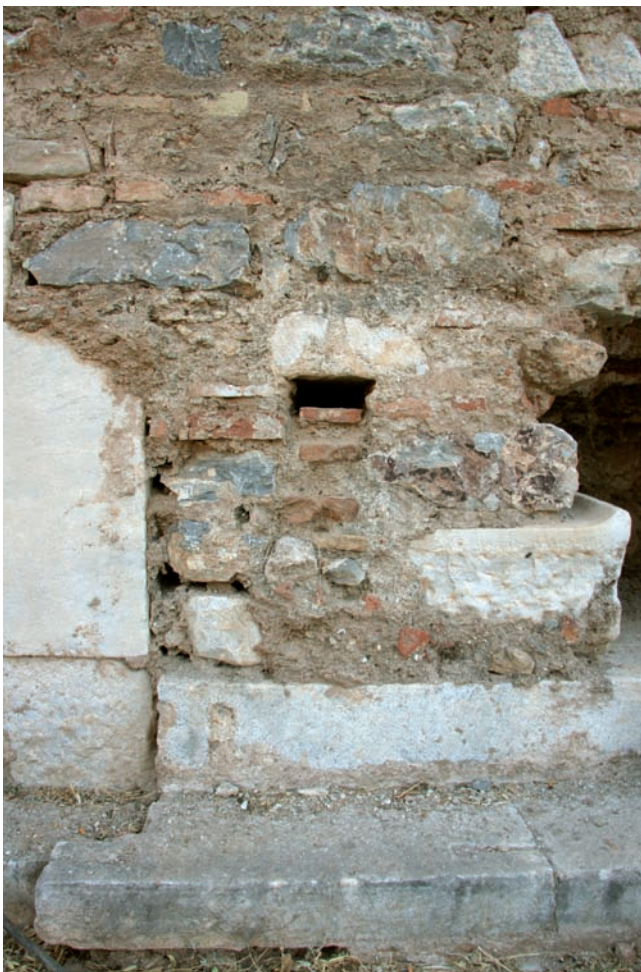
2 »Hestiasaak«. Sekundäre Öffnung in Nordwand zur Wasserentnahme
