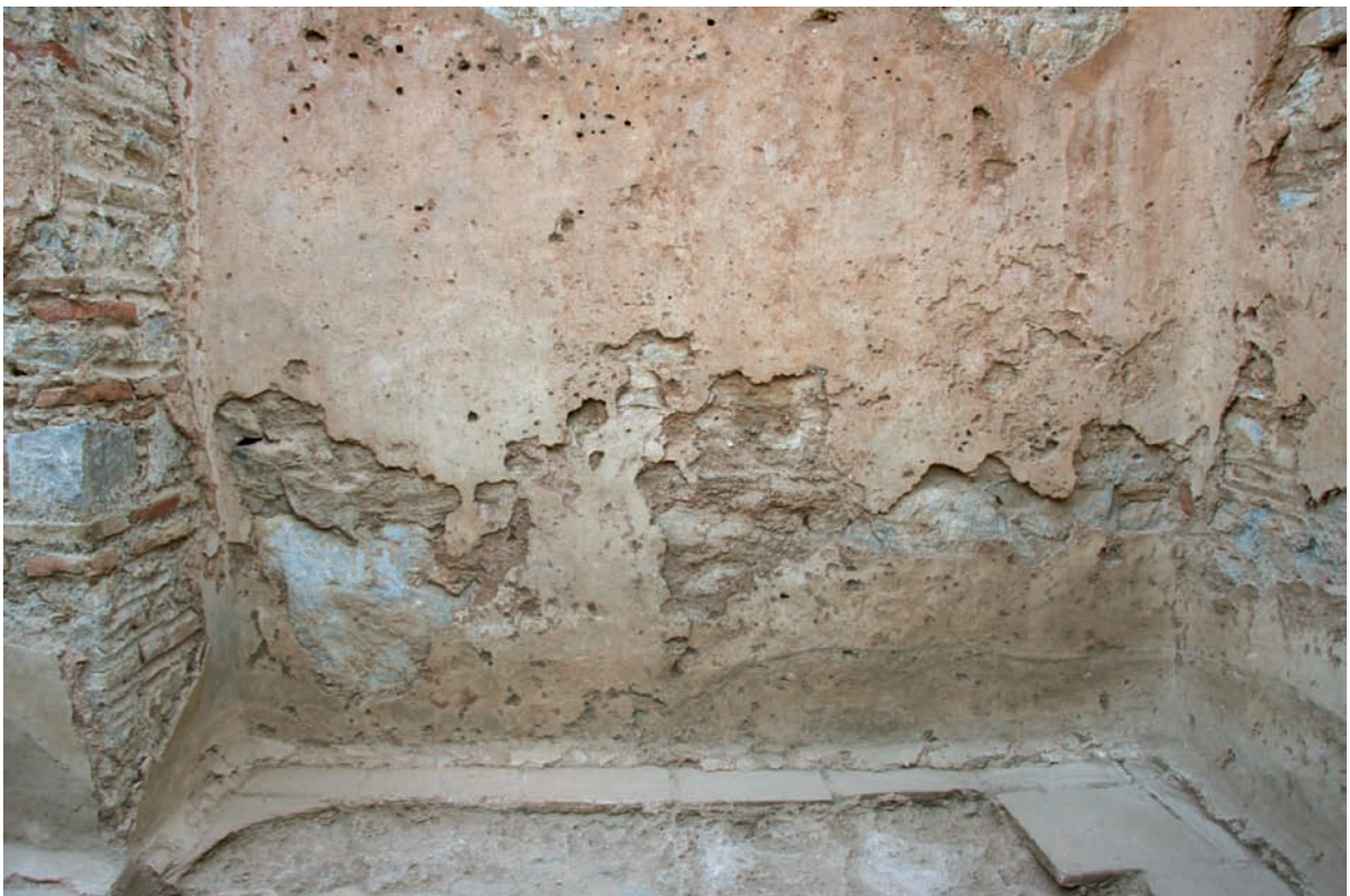
2 Raum 3. Nordwand unterer Teil
