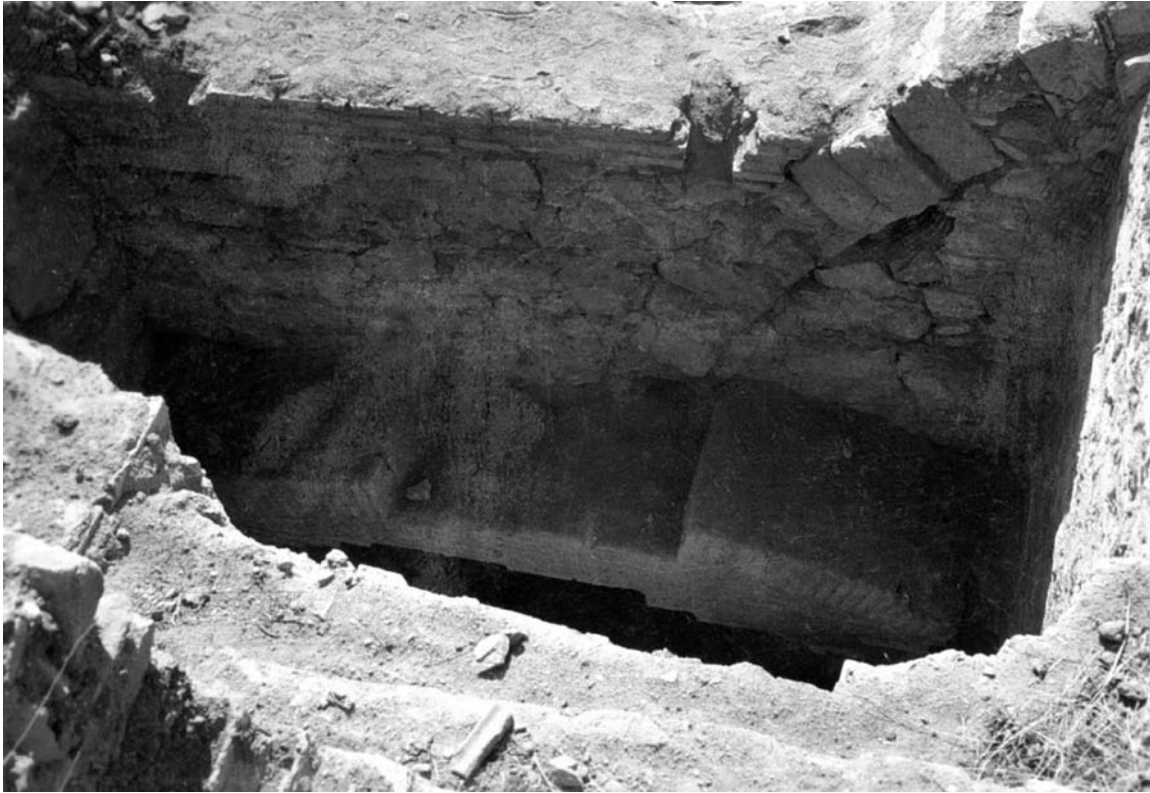
1 Raum 2. Ziegelbogen in Sturzlage
