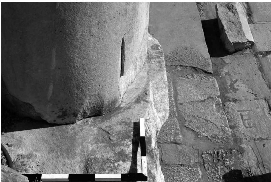
2 ›Neronische Halle‹. Stylobat mit Risslinien zur Markierung der Säulenachse
