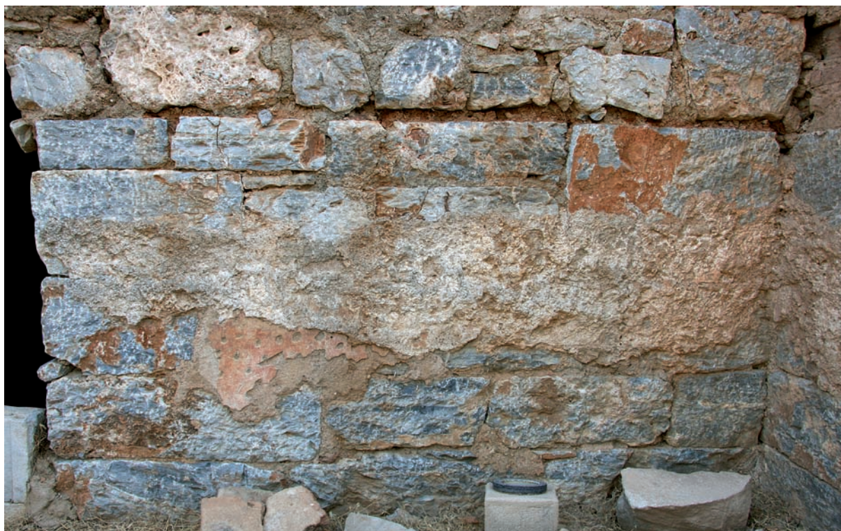
2 Raum 6. Nordwand. Detail Wandmalerei
