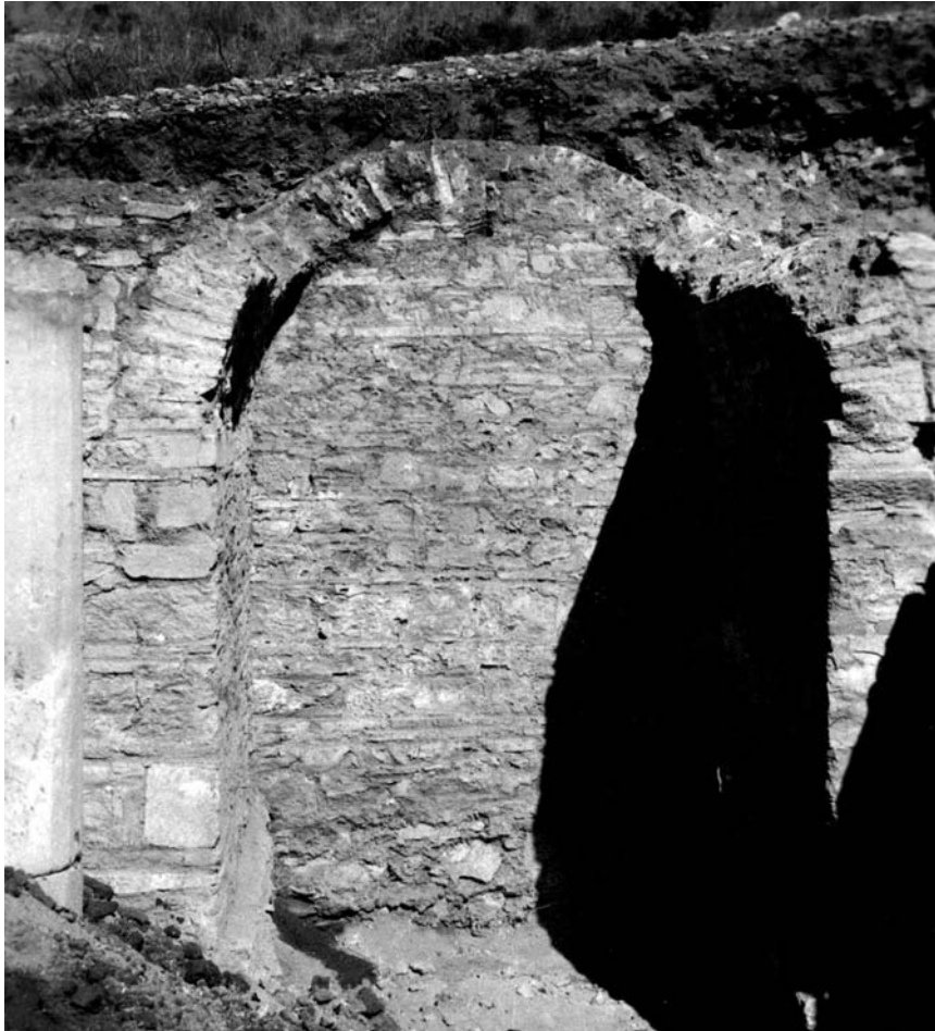
2 Raum 5. Gewölbe vor Absturz der Ostwand
