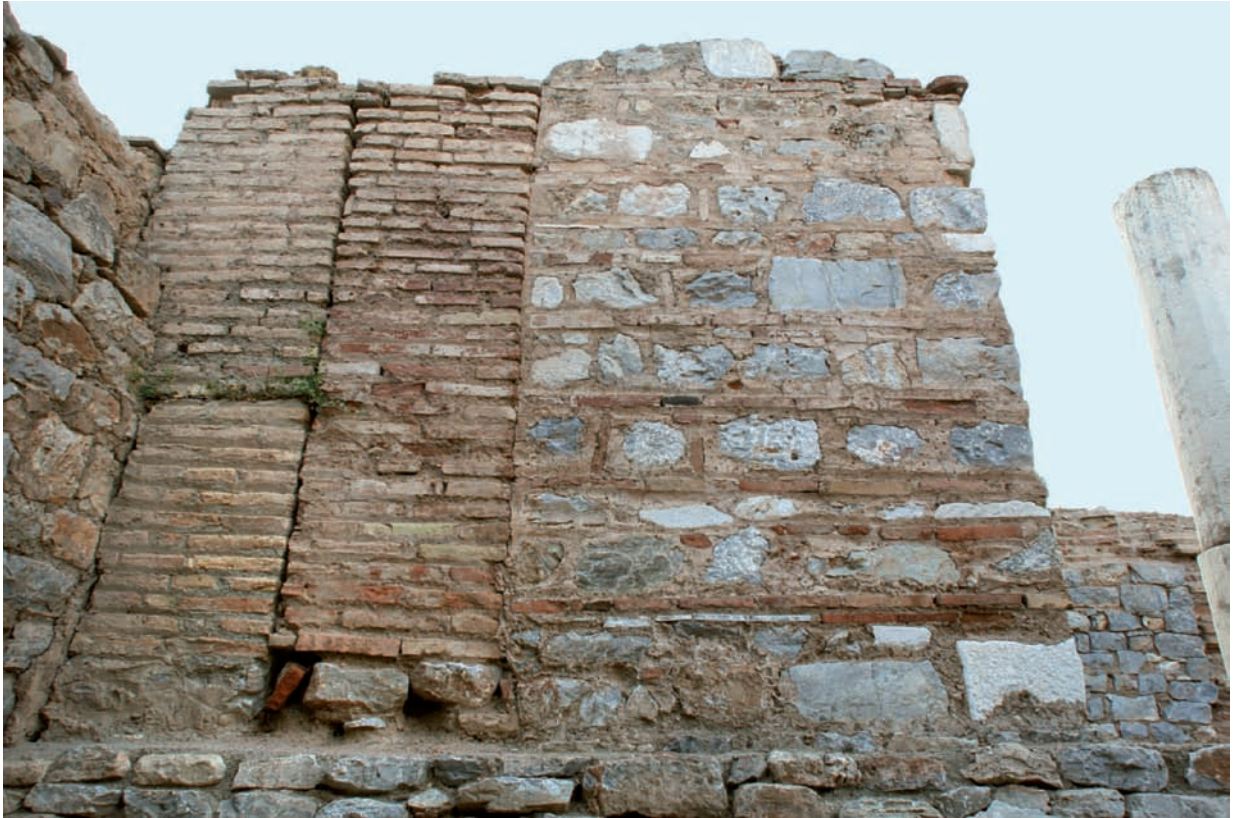
1 Raum 5. Sekundäre Nord-Süd-Mauer von Westen
