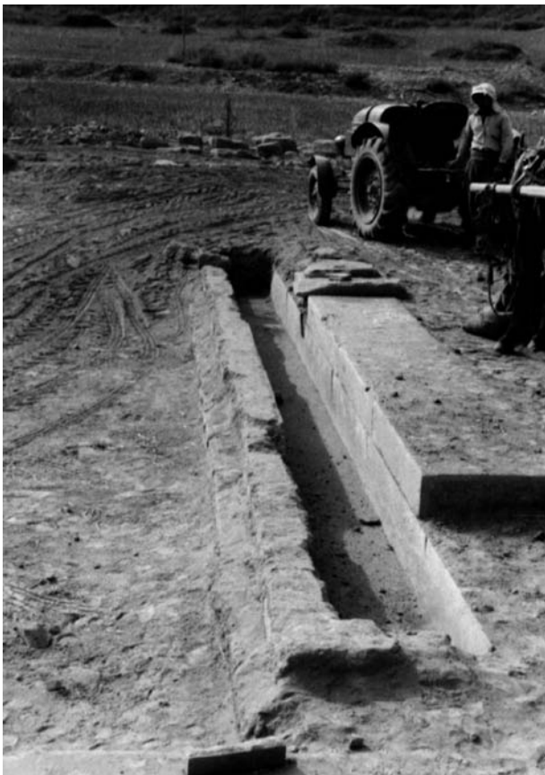
2 Freilegung des westlichen Stylobats des Vorhofes
