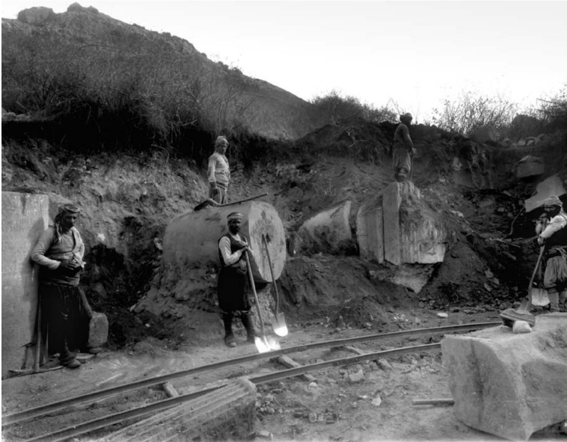
1 Freilegung der »Kuretenhalle« am unteren Embolos
