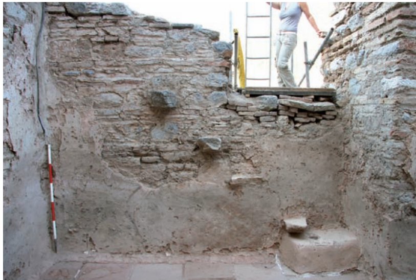
2 Raum 3. Süd- wand
