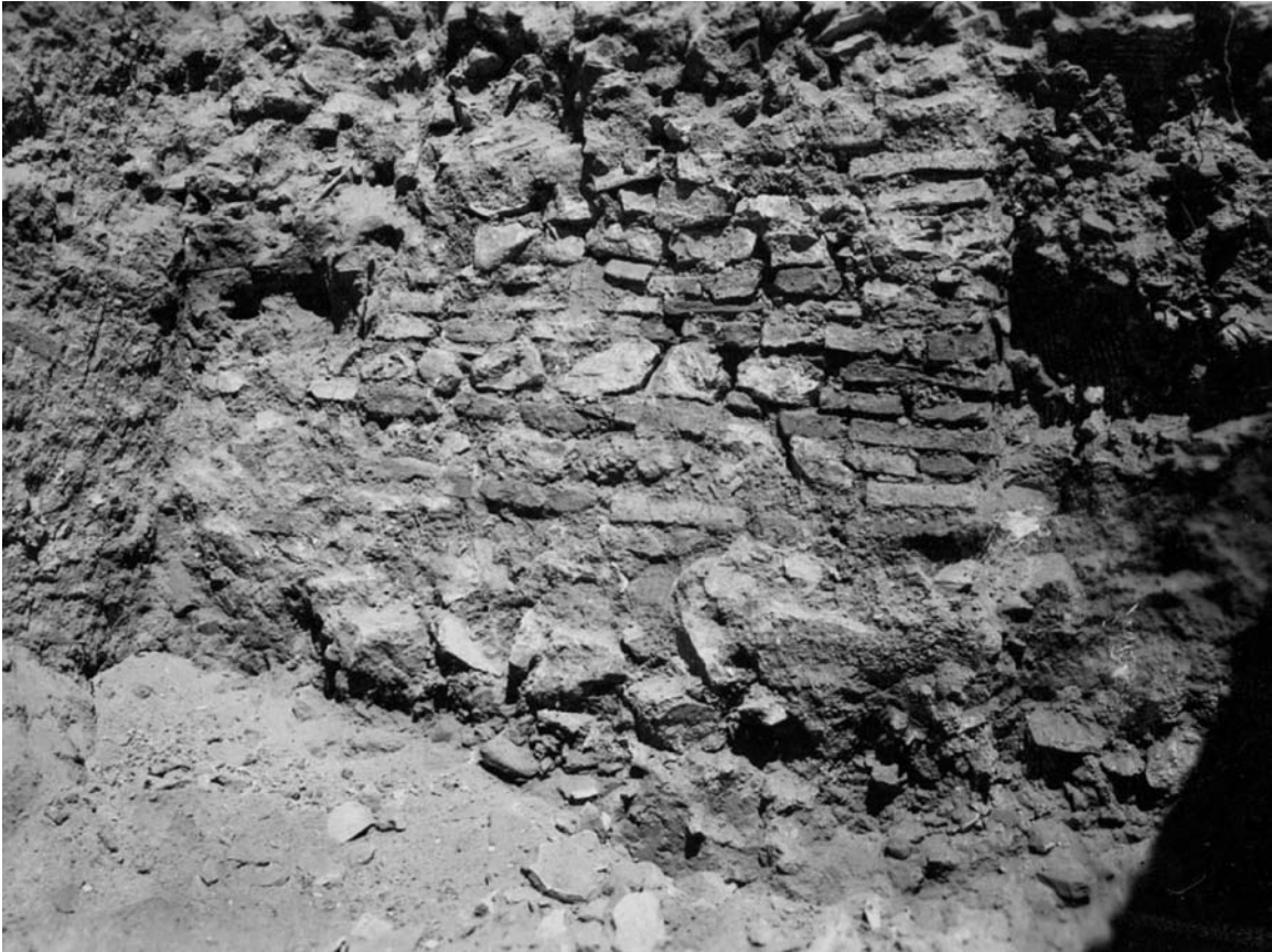
2 Raum 5. Detail der an die Nordwand angeetzten sekundären Mauer
