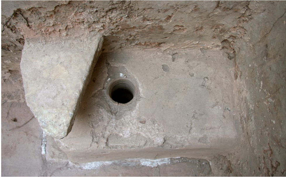
1 Raum 3. Ausfluss des Wasserreservoirs
