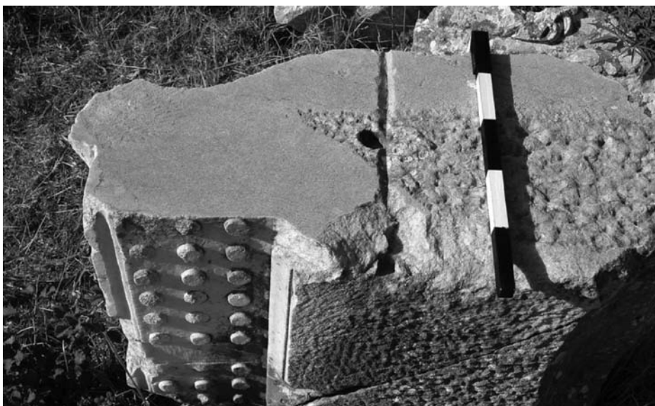
3 ›Neronische Halle‹. Geison: vertikaler Gusskanal an der Stoßfuge
