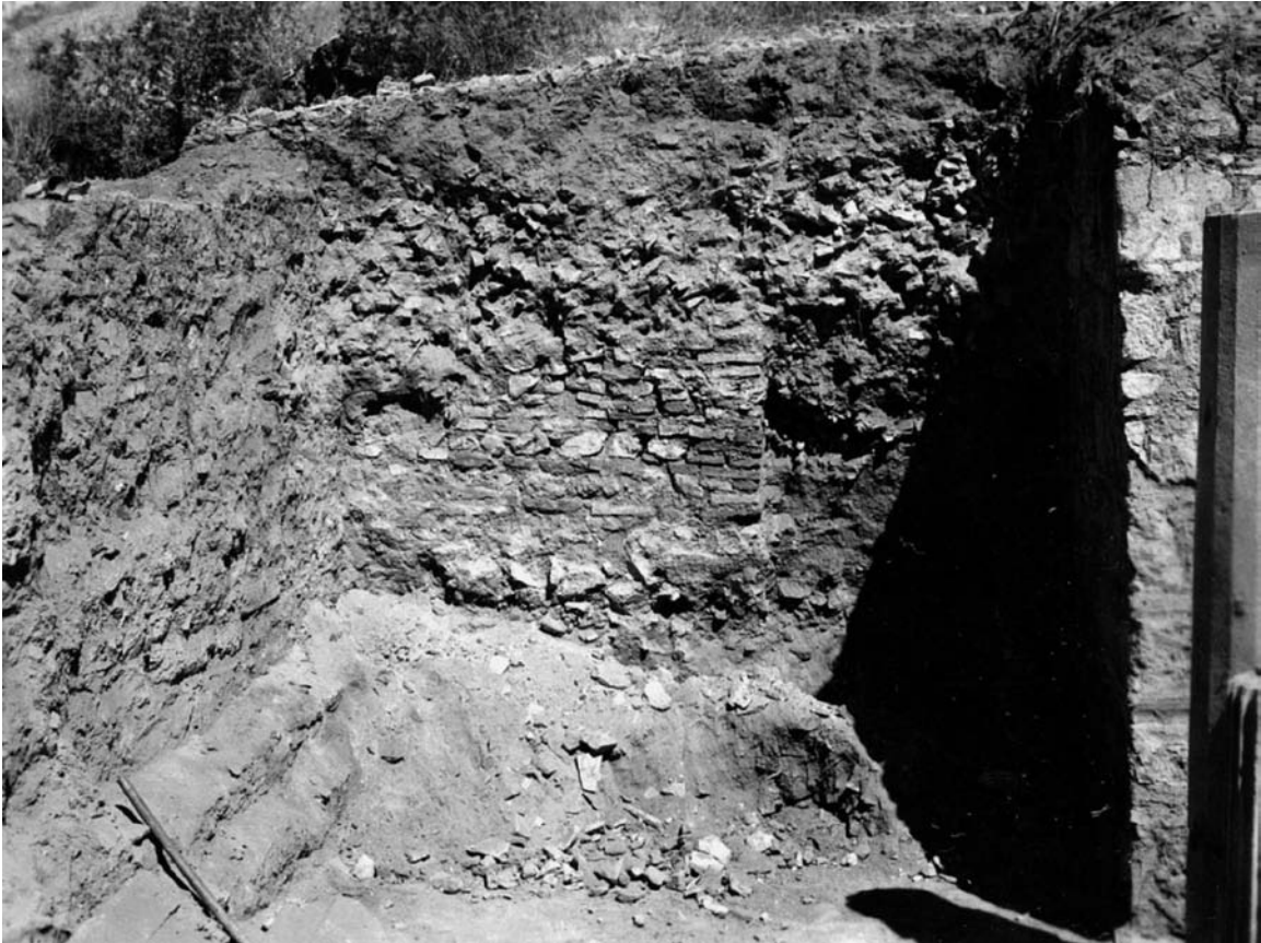
1 Raum 5. An die Nordwand angeetzte sekundäre Mauer
