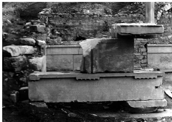
4 Prytaneion. Architekturprobe des dorischen Gebälks der Vorhalle (1961)
