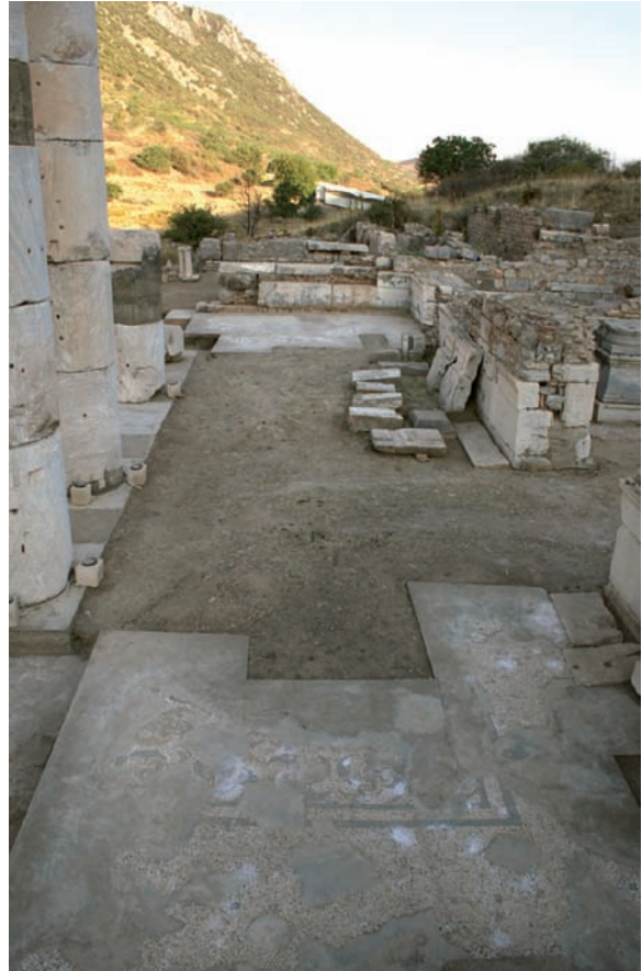
2 Vorhalle von Osten
