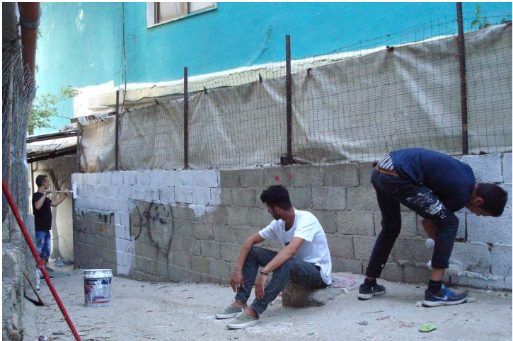
TROIS PEINTRES PROFITENT DU RESTE DE PEINTURE POUR RECOURIR DE BLANC UN MUR EN PARPAINGS GRIS (© CL 2016).
