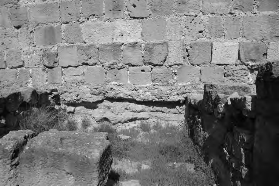
Abb. 11: Byzantinische Mauer östlich der Insula (Aufnahme Verf.)
