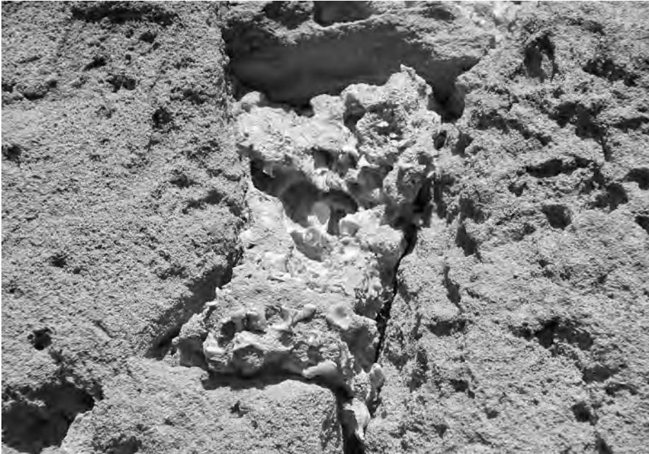
Abb. 27: Byzantinische Stadtmauer, Detail (Aufnahme Verf.)
