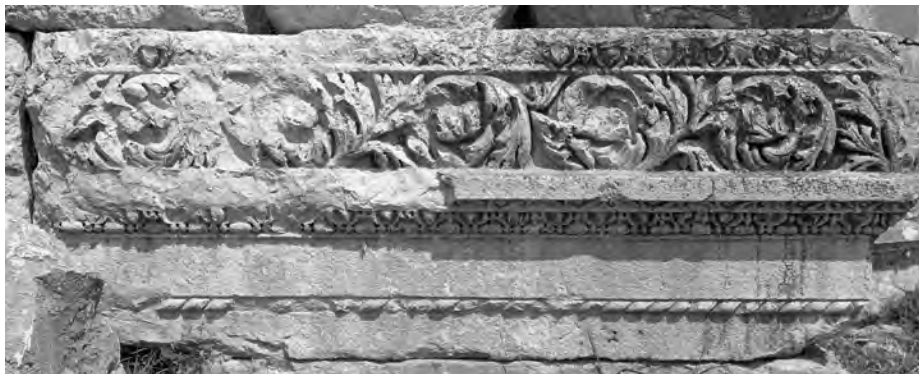
Abb. 7: Block 03 am östlichen Ende der Südfassade
