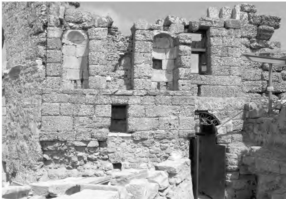
Abb. 17: Nischenwand mit Portikusdurchgang südl. des Bogentores
