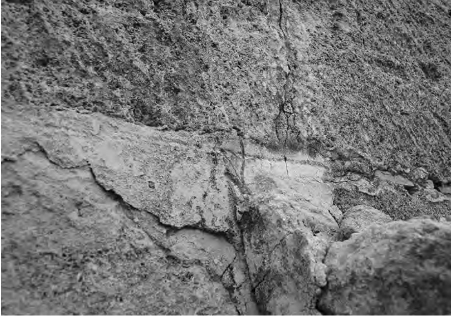
Abb. 30: Verputzreste im Annex (Aufnahme Verf.)
