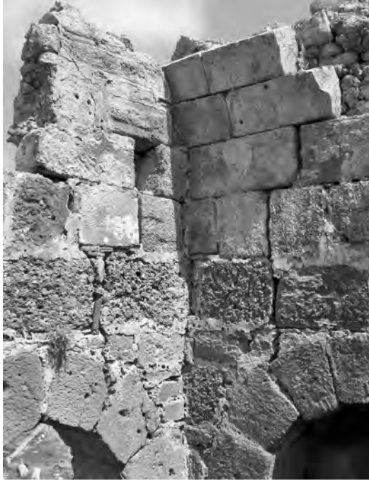
Abb. 8: Turm 1, Turmkammer, Gewölbeansatz
