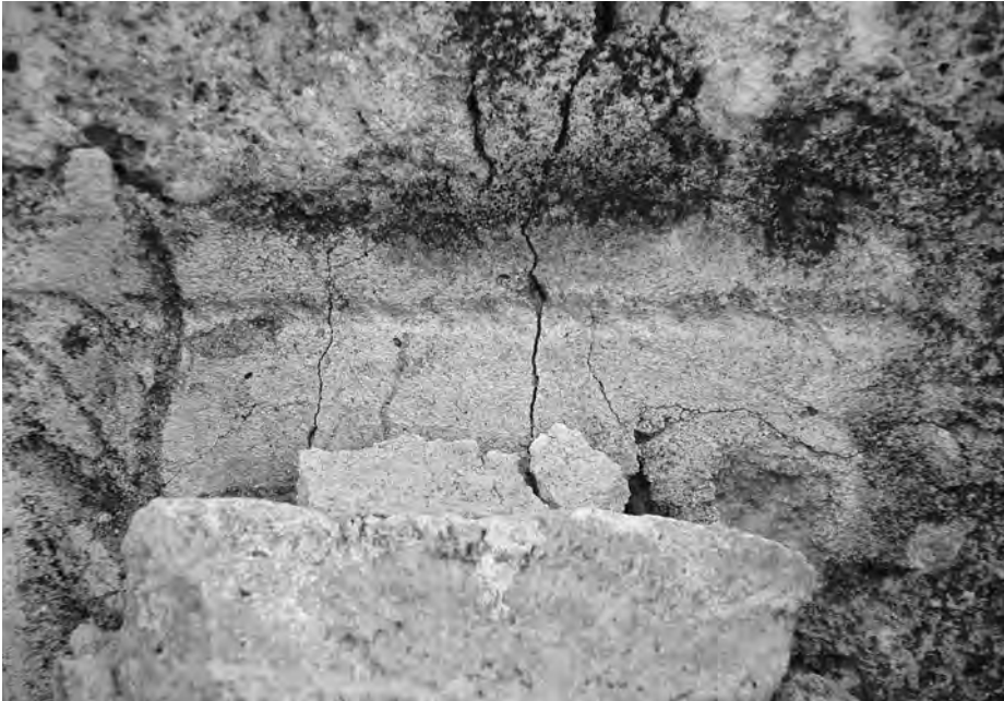
Abb. 31: Verputzreste im Annex, Detail (Aufnahme Verf.)
