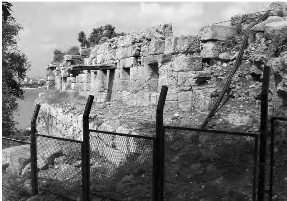
Abb. 28: Kurtine mit Wehgang und Epalxis bei Turm 3
