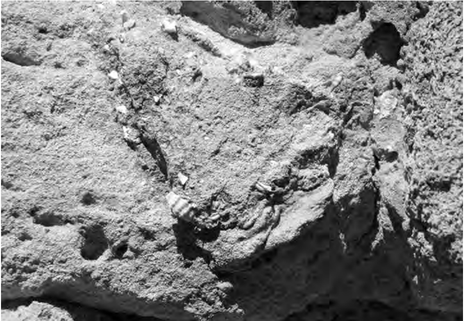
Abb. 29: Mörtelreste am Annex (Aufnahme Verf.)
