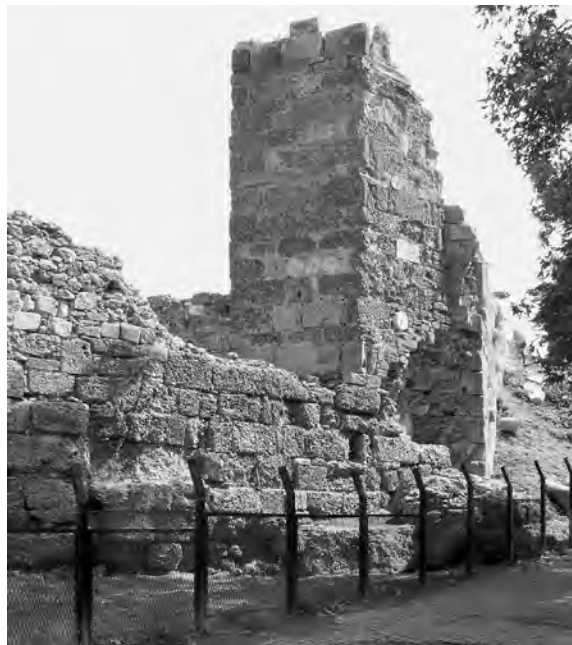
Abb. 29: Turm 3 von NW
