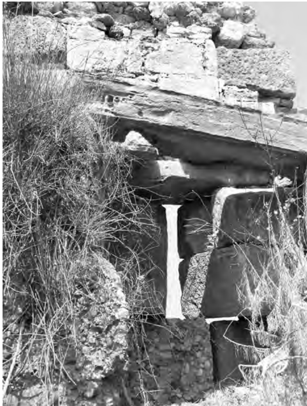
Abb. 11: Schießscharte in Kurtine seitlich von Turm 2
