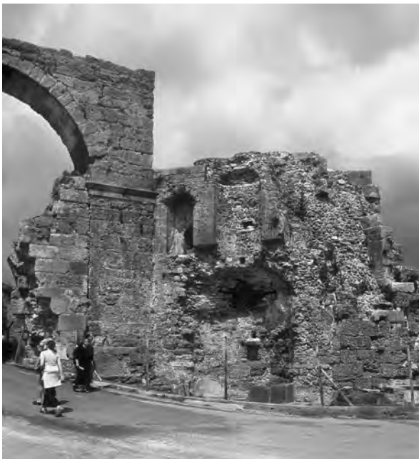
Abb. 21: Stützmauer nördl. des Bogentores
