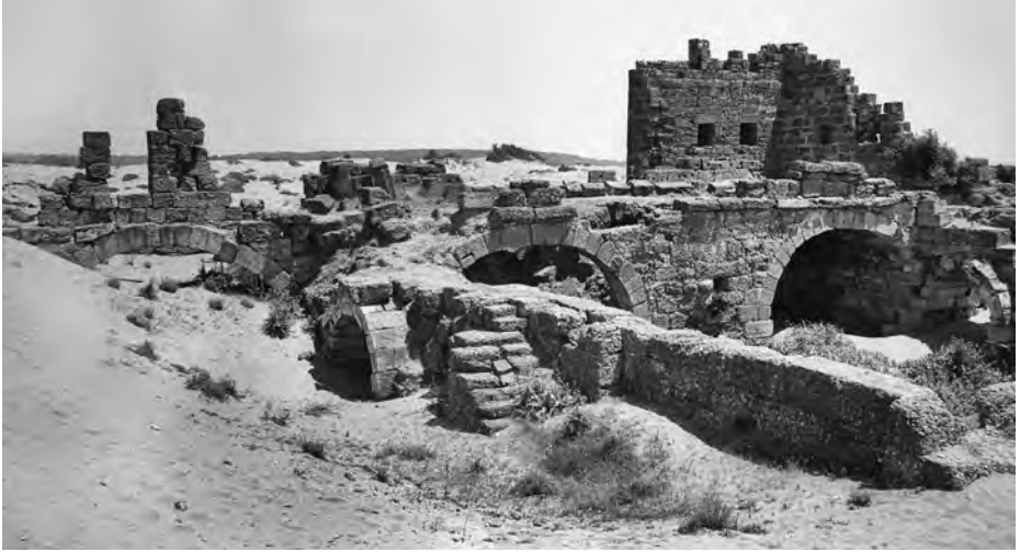
Abb. 34: Toranlage von NW
