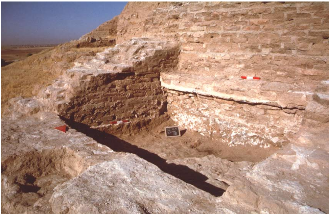
b. Grande Muro di Difesa. Il vano 88. Veduta generale a fine scavo. Nel muro di fondo del vano, 1, si distingue, dal basso, la base di malta su cui poggiano le fondazioni, la risega, e poi l'alzato. Da ENE.
