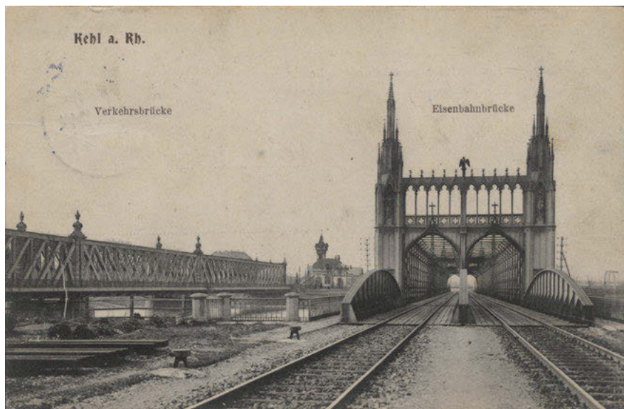
Abb. 6: Straßen- und Eisenbahnbrücke bei Kehl zu Beginn des 20. Jahrhunderts.
