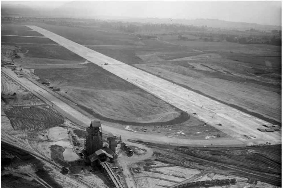
Abb. 9: Bauarbeiten zur Verlängerung der Piste des Flughafens Genf-Cointrin, 15. 8. 1946. Quelle: LBS, 9377.
