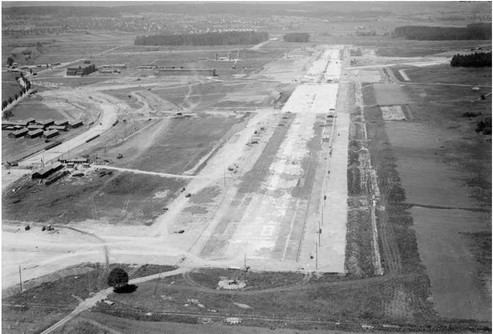
Abb. 12: Die Bauarbeiten an der ersten Piste des Flughafens Zürich-Kloten, 24. 7. 1947. Quelle: LBS, 9821.
