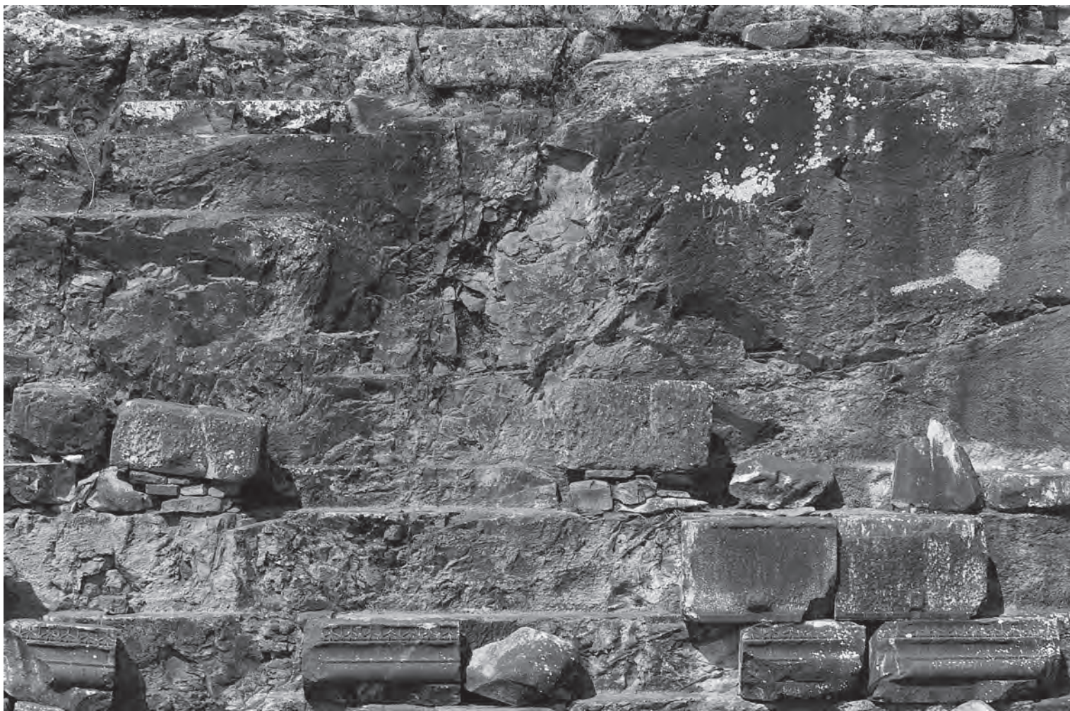
Abb. 14: Felskern im mittleren Teil der Ostseite mit Abarbeitungen für die Lagerfugen der Verkleidungsblöcke
