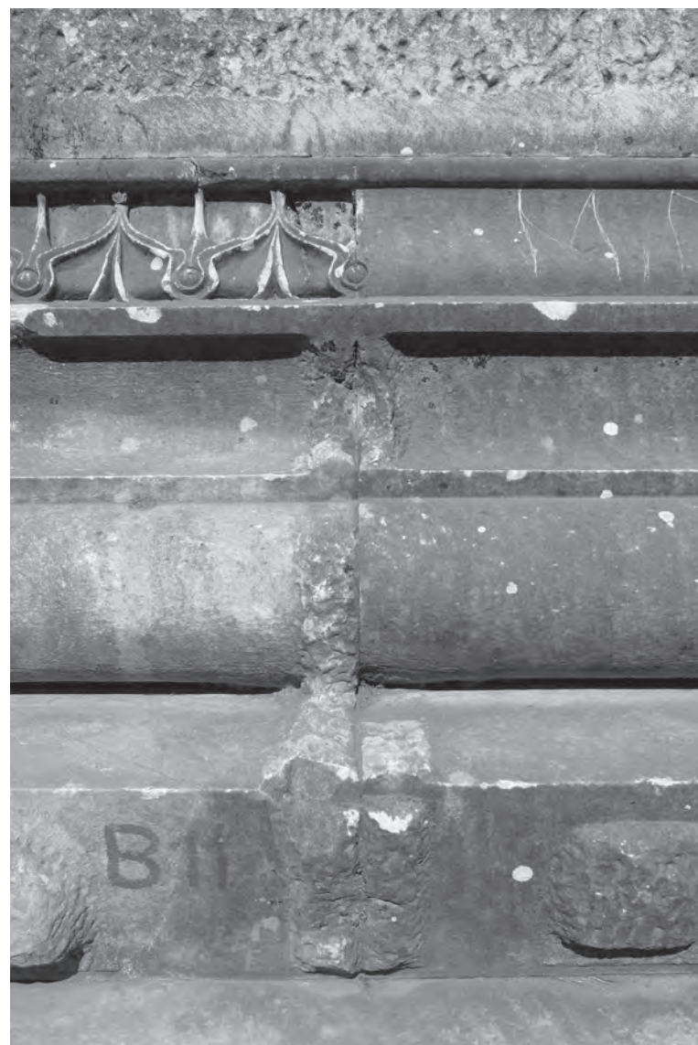
Abb. 12: Sockelprofil der Westseite, Übergang vom ausgearbeiteten zum nicht ausgearbeiteten Kyma an der linken Stoßkante des Mittelblocks
