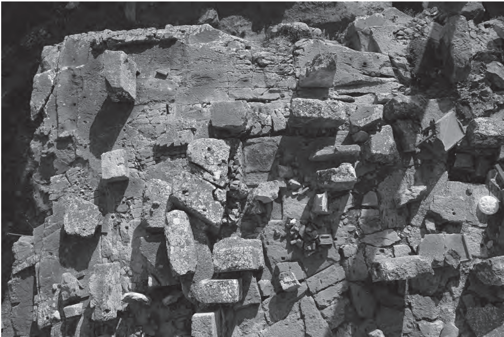
Abb. 36: Aufsicht auf die Südwestecke des Felssockels mit Felsbank auf Stylobathöhe, links oben. Südseite links, Westseite oben.
