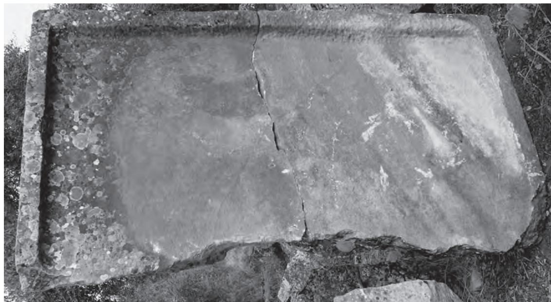
Abb. 54: B02/905+927 Dachplatte der obersten Schicht DP1 mit seitlichem und hinterem Steg
