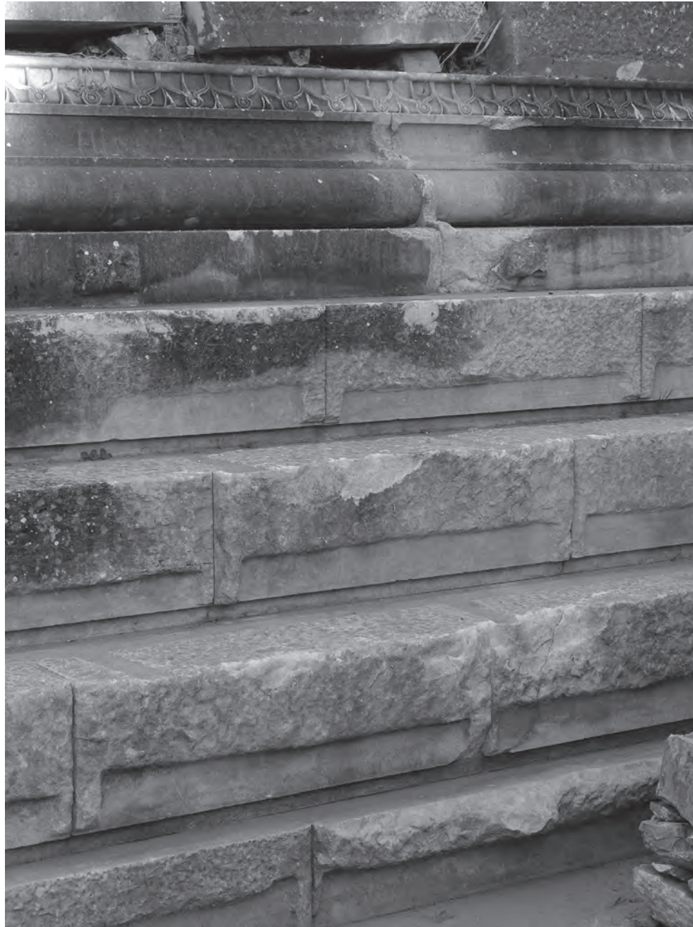
Abb. 10: Krepis und Sockelprofil an der Westseite
