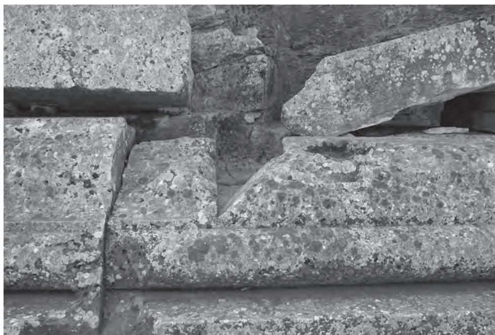
Abb. 24: Linker Sockelprofilblock mit Übergang zur Scheintürschwelle der Nordseite, mit Gehrungsausnehmung für den Gewändelblock
