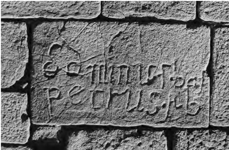
Figura 141. Chiesa di San Martino in Campo, l'iscrizione dell'abate Pietro quando era ancora inserita nel paramento murario
