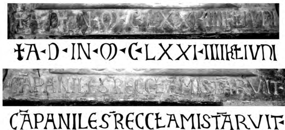
Figura 132. Architrave del portale laterale, dettaglio dell'iscrizione del crollo del campanile
