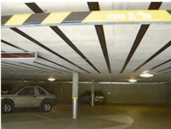
Abb. 2 Verstärkung einer Stahlbetondecke mit aufgeklebten CFK-Lamellen (Quelle: [bm engineering 2017]) ( http://doi.org/10.33968/9783966270021-01-A-02 )
