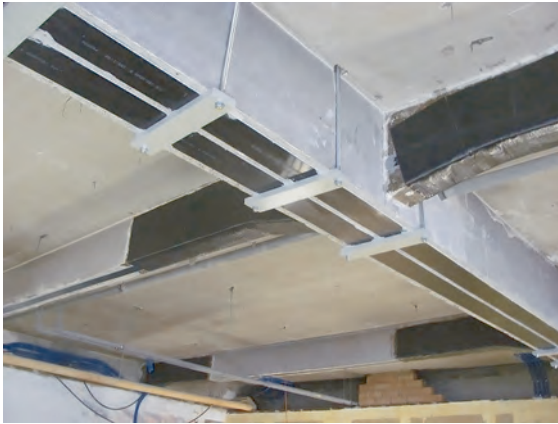
Abb. 1 Verstärkung eines Stahlbetonunterzugs mit aufgeklebten CFK-Lamellen (Quelle: [S&P 2017]) ( http://doi.org/10.33968/9783966270021-01-A-01 )
