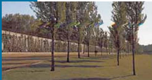
Figura 20 Ai margini del prato il muro di contenimento delle acque di piena.
