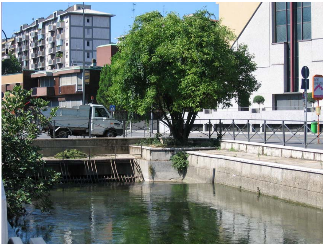
Figura 10 Il naviglio sopraffatto dallo sviluppo urbano perde il proprio ruolo e scompare nel sottosuolo della città.
