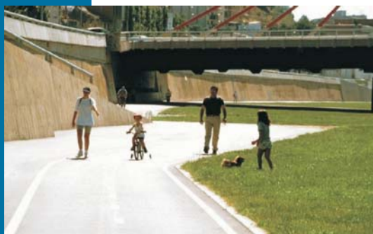
Figura 34 La fruibilità delle sponde è garantita da un sistema di allarme in caso di ondate di piena.
