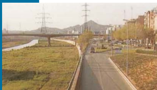
Figura 14 La riqualificazione e il ridisegno dell'invaso fluviale ha permesso di migliorare la definizione dei margini urbani prospicienti il fiume.
