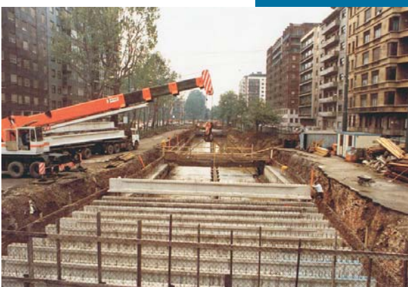
Figura 123 Rifacimento della copertura del cavo Redefossi in via Monte Santo, Milano, Archivio Storico F.C.A.
