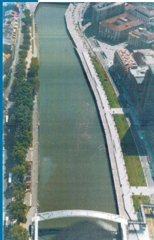
Figura 23 Vista aerea dell'ambito di progetto dopo il completamento dei lavori di riqualificazione dei margini fluviali.
