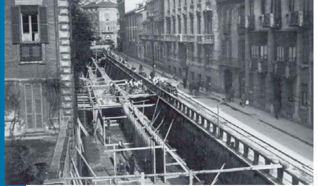
Figura 120 Lavori di copertura del naviglio interno in via Senato, 1929-1930, Milano, Archivio Storico F.C.A.
