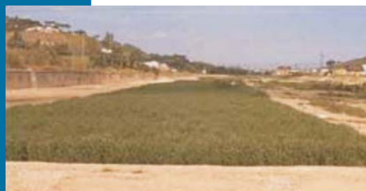
Figura 21 L'area ai margini del canale d'acqua soggetta al particolare trattamento terziario per il miglioramento della qualità delle acque.
