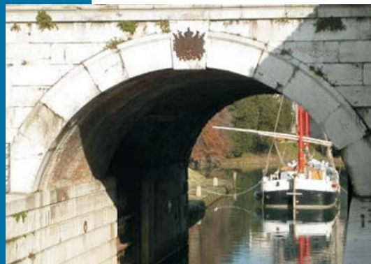
Figura 22 Il recupero e la valorizzazione della rete fluviale ha consentito di riaprire i canali alla navigabilità.
