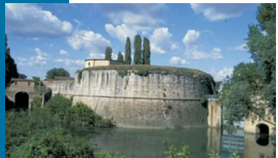
Figura 14 Le acque che circondano il sistema fortificato cinquecentesco.
