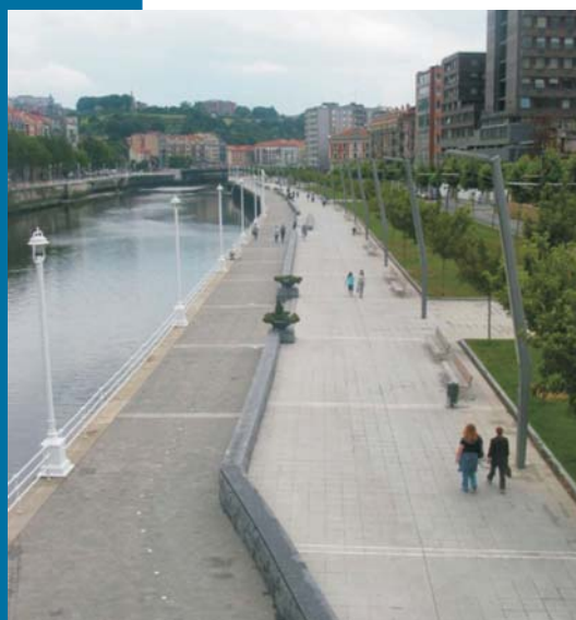
Figura 24 I nuovi spazi pubblici di relazione con il fiume si accostano e si susseguono nella sezione compresa tra la banchina e i fronti edificati.
