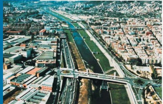
Figura 7 L'immagine del tratto urbano del fiume in Santa Coloma de Gramenet evidenzia la nuova sezione del fiume, l'estesa area verde lungo i margini e il nuovo percorso pedonale e ciclabile che disegna il limite urbano dell'invaso fluviale.
