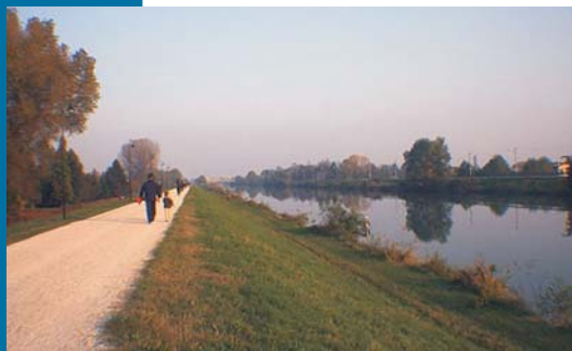
Figura 5 I percorsi lungo le sponde dei corsi d'acqua esterni.
