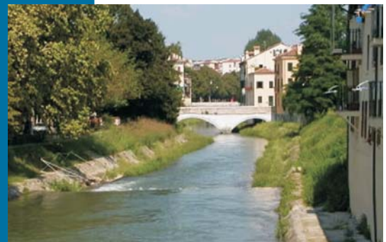
Figura 3 I tratti canalizzati dei corsi d'acqua all'interno del tessuto urbano.
