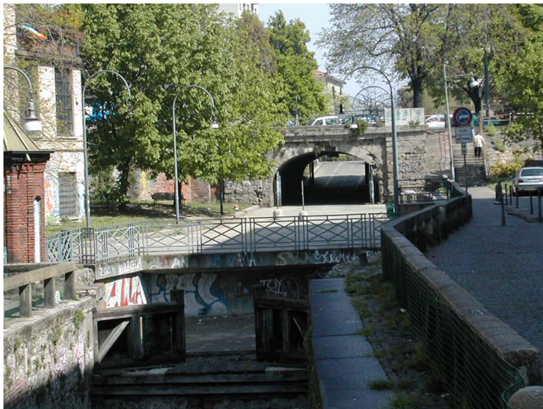
Figura 81 Il ponte delle Gabelle e l'antica conca dell'Incoronata.
