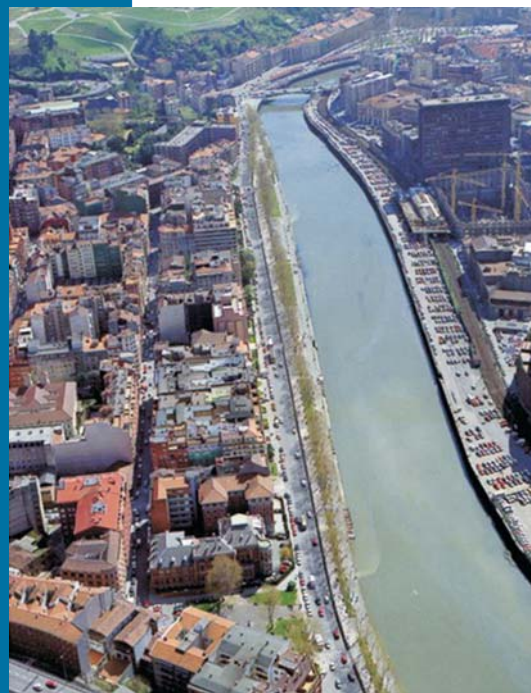
Figura 18 Vista sull'area della ribera de Uribitarre prima dell'intervento di riqualificazione dei margini fluviali.
