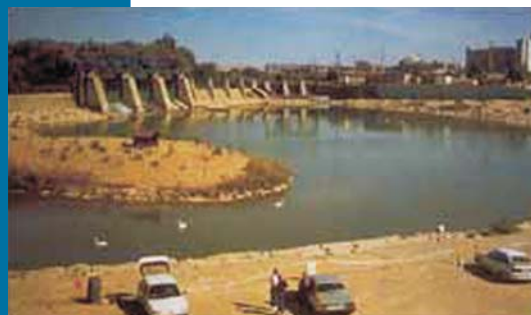
Figura 30 Il lago e la presa di derivazione del canale Seròs.
