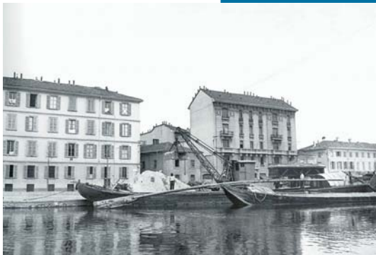
Figura 62 Barconi, depositi di sabbia e mezzi meccanici lungo le banchine della Darsena , 1920 circa.
