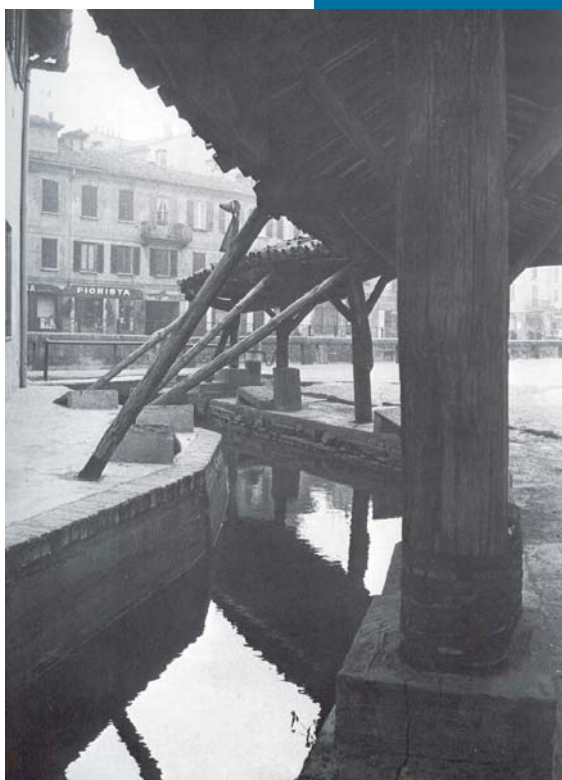
Figura 111 La struttura del lavatoio in Vicolo dei Lavandai.
