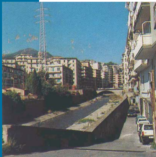
Figura 1 Il tracciato fluviale nei pressi del ponte dei Cacciatori dell'Irno.
