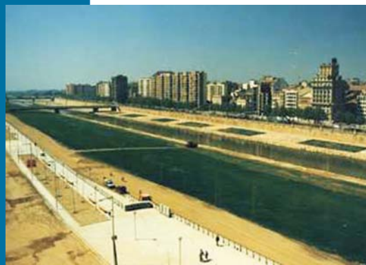
Figura 17 I lavori di sistemazione delle sponde lungo il corso del fiume Segre.
