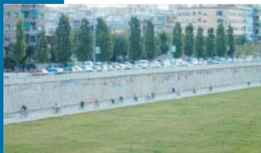
Figura 31 Gli alti muri di contenimento definiscono i limiti dell'invaso fluviale e delimitano gli estesi percorsi pedonali e ciclabili.
