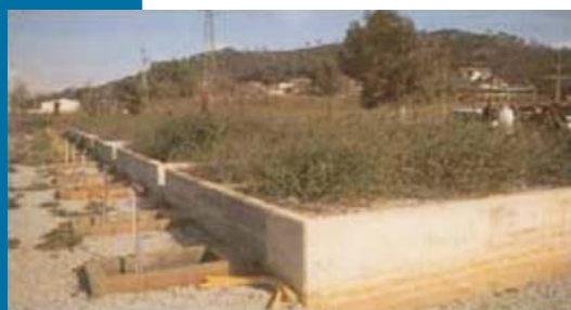
Figura 24 La sperimentazione del trattamento prima dell'intervento lungo i margini del Besòs.
