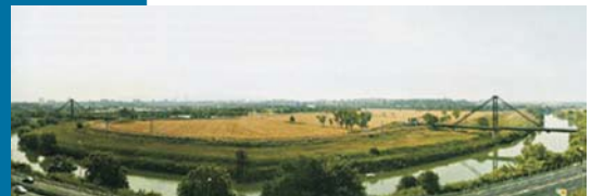
Figura 3 L'ansa del fiume ai margini del tracciato autostradale.
