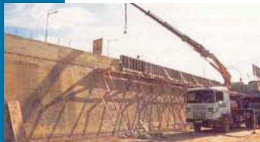
Figura 12 L'innalzamento del muro di contenimento per aumentare la capacità idraulica della sezione fluviale in caso di piena.
