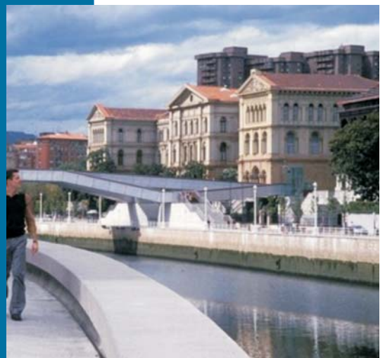
Figura 16 La riqualificazione dei margini fluviali e l'inserimento di nuove funzioni culturali ha restituito fruibilità agli spazi lungo il Nervión.
