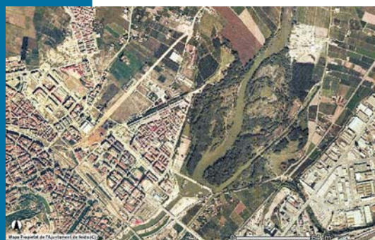
Figura 29 L'ambiente naturale a monte del tratto urbano del fiume.
