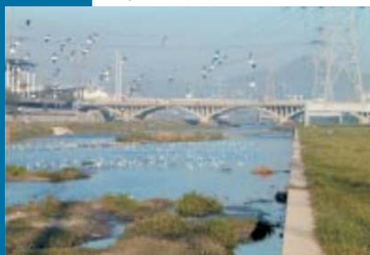
Figura 15 L'invaso fluviale occupato dalla vegetazione prima dell'intervento.
