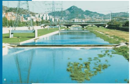
Figura 16 L'immagine della sezione fluviale successiva alla realizzazione dell'intervento.
