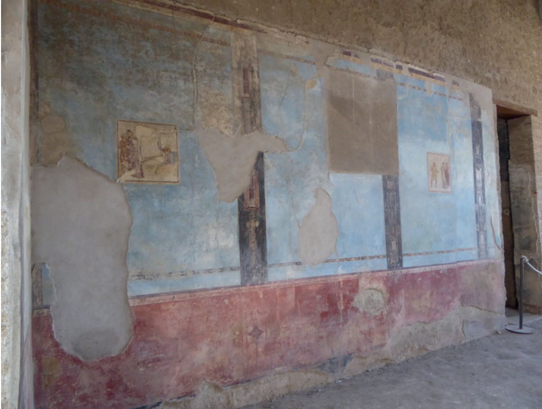
Abb. 334: Casa dei Quadretti teatrali (I 6,11), Atrium (b), Ostwand.
