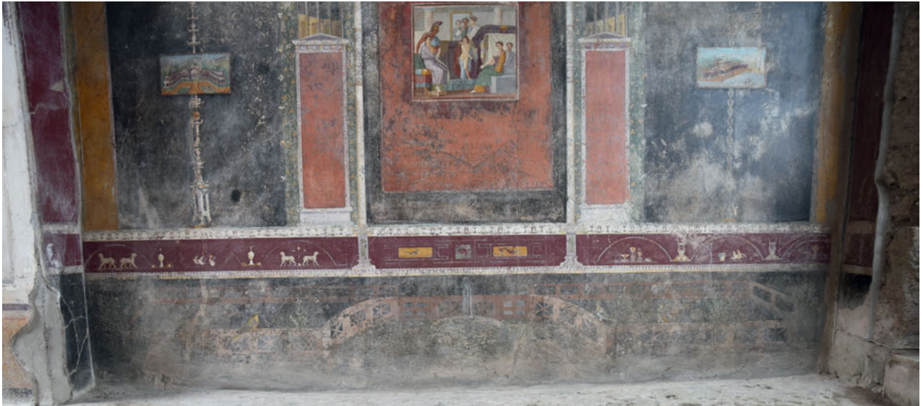
Abb. 289: Casa di Marcus Lucretius Fronto, Tablinum, Sockel- und Predellazone der Nordwand.
