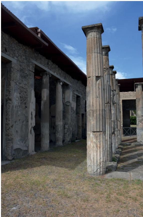
Abb. 82: Casa di M. Epidius Rufus (IX 1,20), Blick auf die Westala mit ionischen Säulen im Durchgang.
