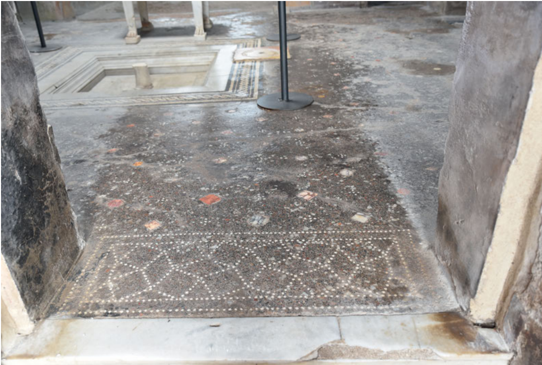
Abb. 277: Casa di Marcus Lucretius Fronto, Schwellbereich zwischen Fauces und Atrium.
