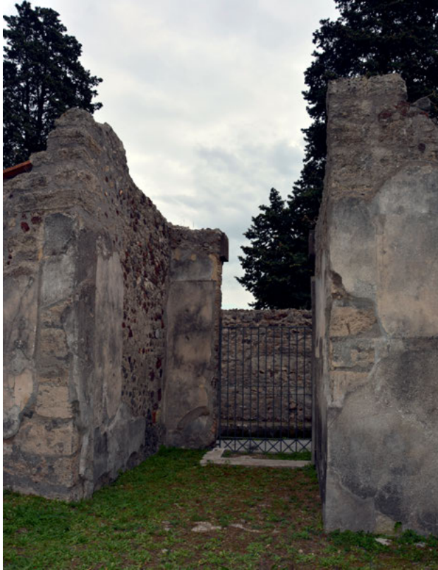
Abb. 141: Casa del Labirinto, Vestibulum mit Über-Eck-Eingang und Fauces (1), Blick vom Westatrium (3) zurück.
