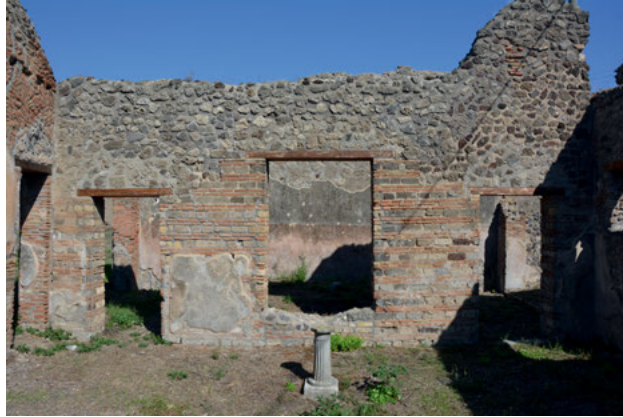
Abb. 316: Casa di P.L.F. (IX 6,3), Blick auf die Atriumsrückwand, die den Übergang zu Garten (f) herstellt.
