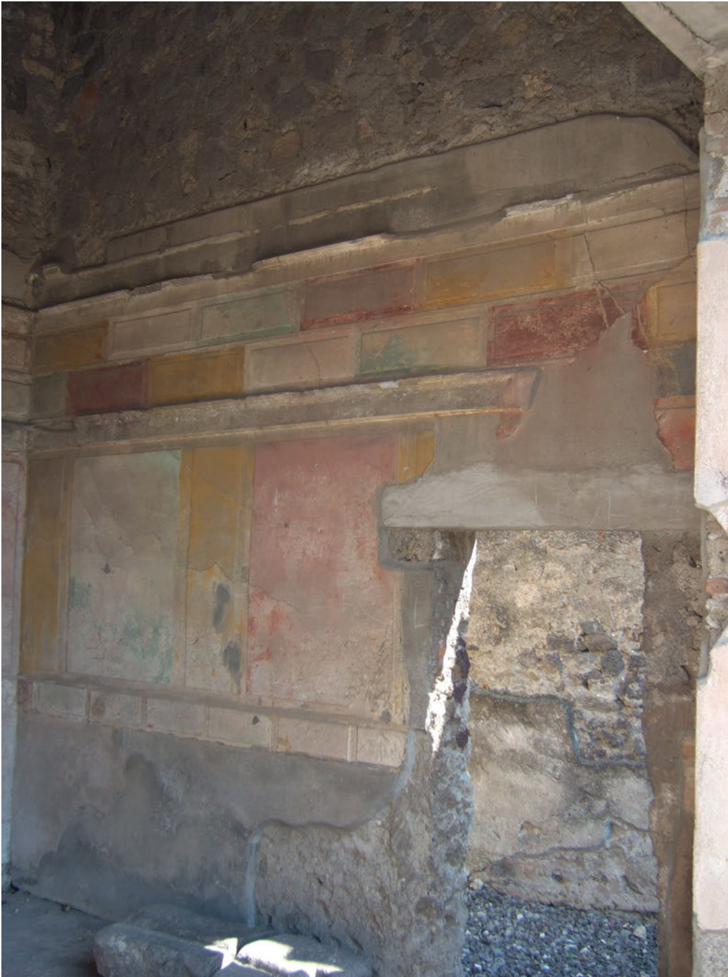
Abb. 92: Domus VI 2,13, Tablinum (4), Südwand.
