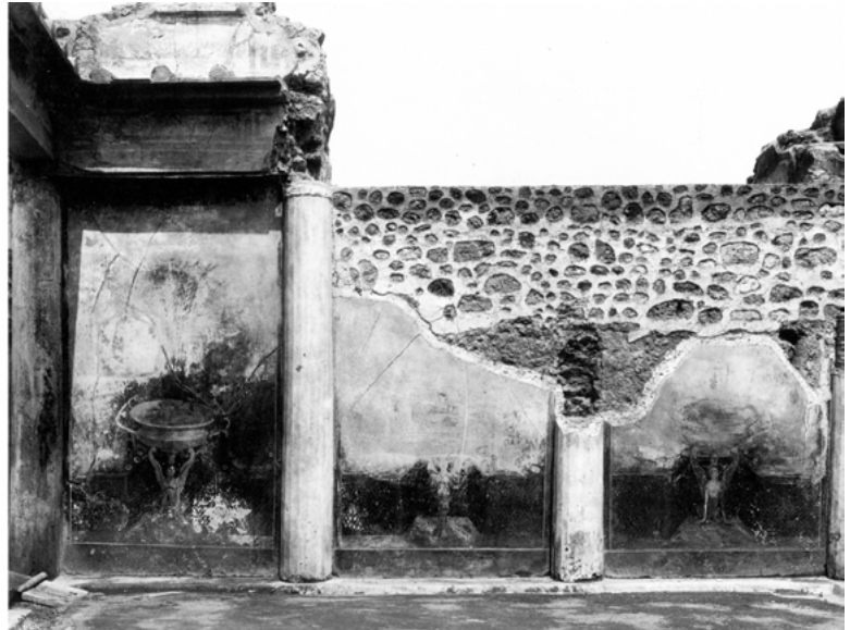
Abb. 344: Domus VII 6,28, Peristyl (4) nördliche Peristylrückwand.
