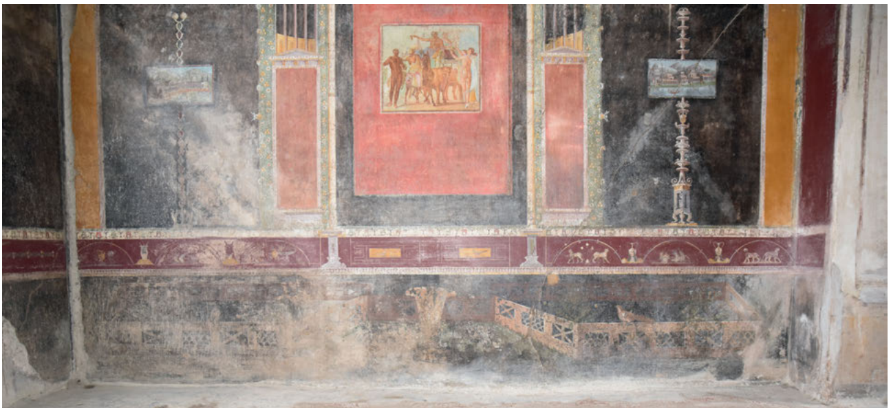
Abb. 290: Casa di Marcus Lucretius Fronto, Tablinum, Sockel- und Predellazone der Südwand.
